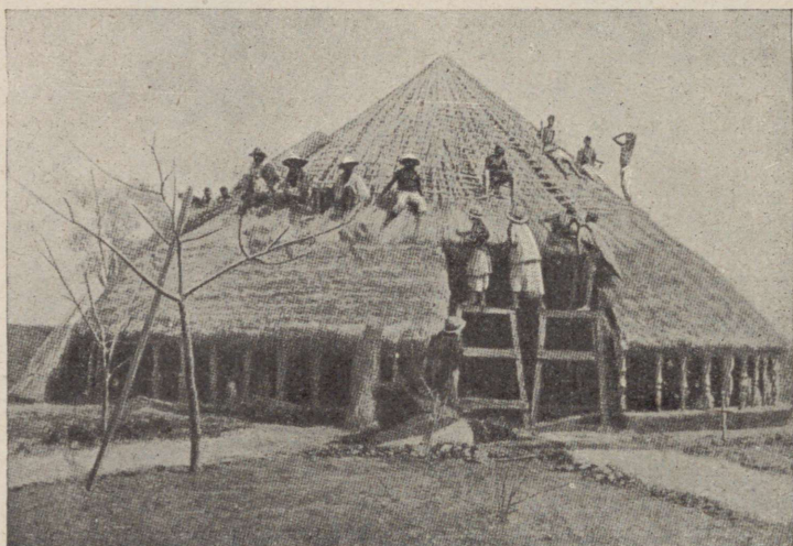
144. joonis. Ümmarguse ühiselamu õlgkatuse tege- mine Lääne-Sudaanis. Kui katus valmis saab, siis pannakse tipu otsa suur suletutt.
