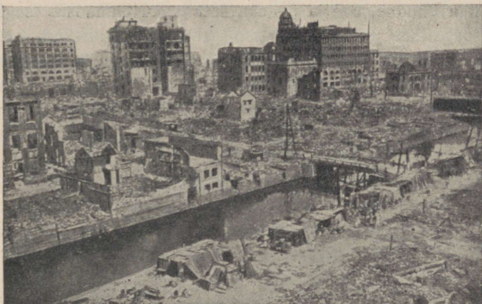
55. joonis. Tokio pärast 1923. a. maavärinat. Pange tähele rusuhunnikuid ja purunenud ning viltuvajunud raudbetoonist „pilvelõhkujaid“!
