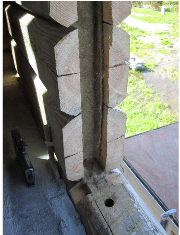
Joonis 54. Tenderposti alumine tappliide. Vasakpoolsel pildil on näha ava allosas olev süvend kuhu koguneb sadevesi millel ei ole võimalik seal hiljem välja valguda. Parempoolsel pildil on näha korrektne tenderposti alumine tappliide – sadevee tungimine konstruktsiooni on takistatud ning välisküljes olev tapipesa on valmistatud selliselt, et oleks tagatud sinna sattunud vee väljavalgumine.
