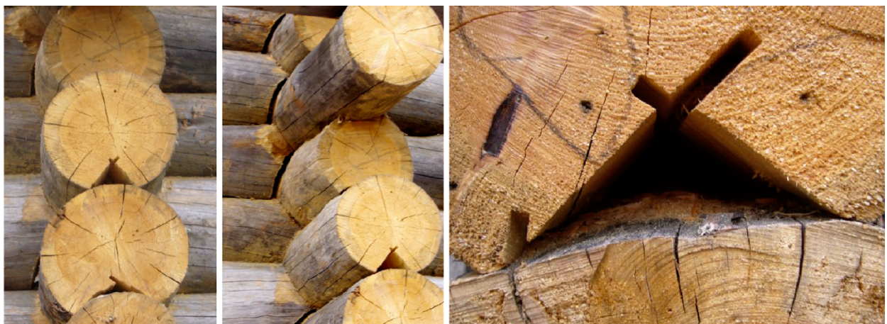
Joonis 32. V-kujulised ning teravate sisselõigetega varad (Allikas: www.wikikko.info )
