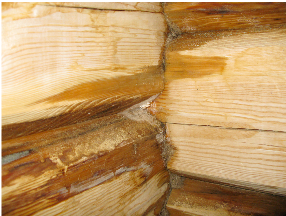
Foto 5. Vee- ja seenkahjustused esimese korruse edelanurgas
