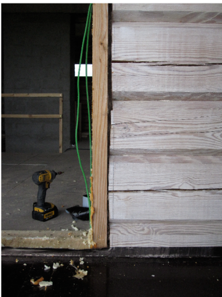
Joonis 55. Saulepa palkmaja. Vesi on tunginud konstruktsiooni ning siseruumidesse mittekontaktsete liitepindade kaudu. Tenderposti alumisse tapipesa tehtud süvenditesse on kogunenud sadevesi millel ei ole olnud võimalik seal välja valguda. Geomeetriliselt ebasobivate tappliide ning erakordselt hooletult teostatud tööde tulemusena vajasid korrigeerimist hoone kõikide avade servad ja vahetamist kõik hoone tenderpostid (Foto: Andres Veel)
