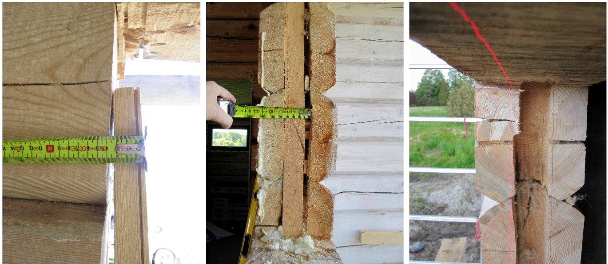
Joonis 56. Lubamatud lahendused palkhoone avade vormistamisel. Vasakpoolsel pildil on näha, et ehitaja on kasutanud 2x2,1m ukseavas tenderposti asemel ristlõikega 35x50mm liistu – selline lahendus on lubamatu. Keskmisel ja parempoolsel pildid on näha ebakvaliteetsed tööd, mida ehitaja on püüdnud parandada puuklotside ja montaazivahuga. Selline asjatundmatus ning hooletus põhjustavad olulist konstruktsiooni stabiilsuse vähenemist ning niiskustehnilisi probleeme (Foto: Andres Veel)
