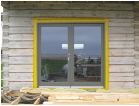
ISOVER RKL Facade teibiga isoleeritud avatäited.
