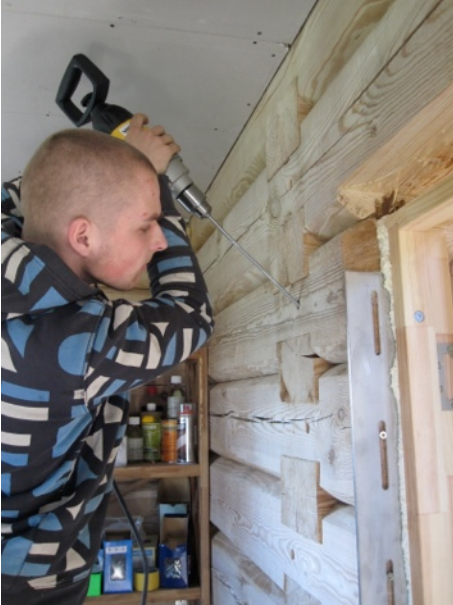
Tihendatud ja kokku taotud nurgatapi fikseerimine FS WT-T-8,2 x 190 mm puidukruviga.
