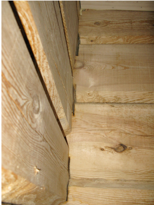
Foto 3. Seinte väljavajumise tõttu on tapid avanenud kuni 3cm laiuselt.
