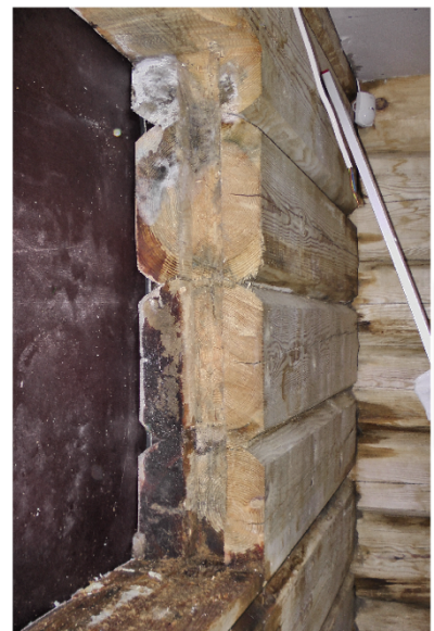
Joonis 55. Saulepa palkmaja. Vesi on tunginud konstruktsiooni ning siseruumidesse mittekontaktsete liitepindade kaudu. Tenderposti alumisse tapipesa tehtud süvenditesse on kogunenud sadevesi millel ei ole olnud võimalik seal välja valguda. Geomeetriliselt ebasobivate tappliide ning erakordselt hooletult teostatud tööde tulemusena vajasid korrigeerimist hoone kõikide avade servad ja vahetamist kõik hoone tenderpostid (Foto: Andres Veel)
