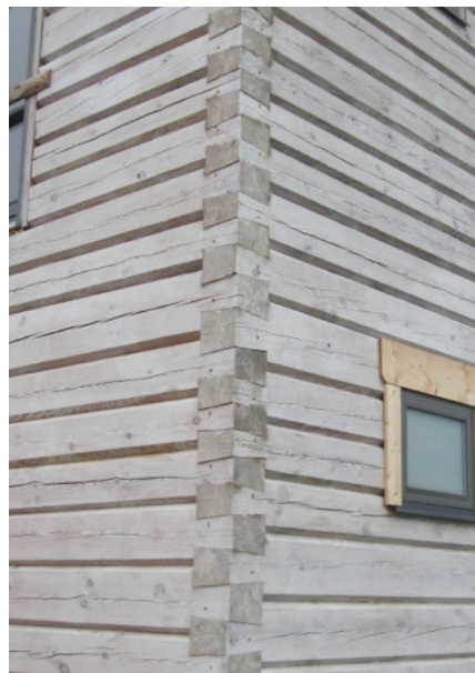
Tihendatud, kokku taotud ja FS WT-T-8,2 x 190 mm puidukruviga fikseeritud nurk kohas, kus sein kaetakse tulevikus tuuletõkke ning vooderdusega ja puupunne ei paigaldada.
