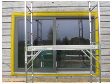
ISOVER RKL Facade teibiga isoleeritud avatäited.
