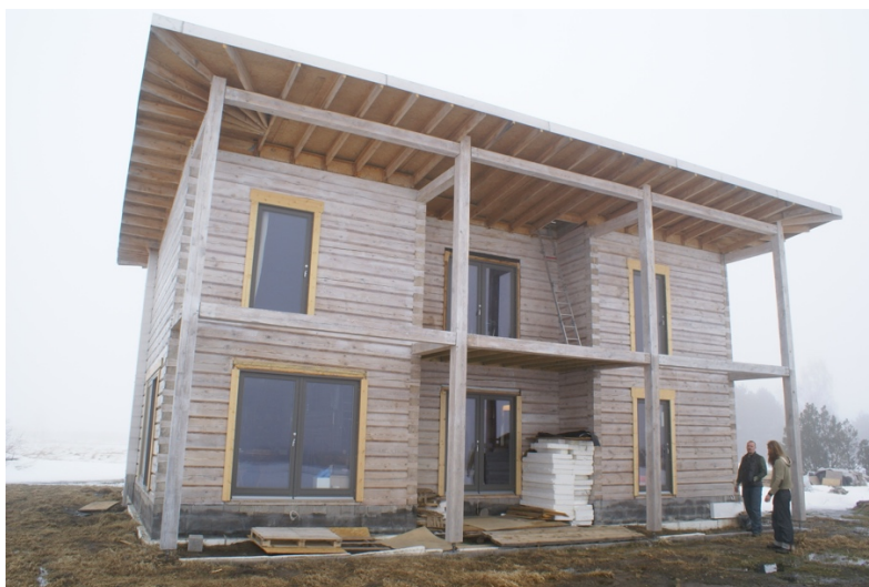
Joonis 7. Kahekorruseline, igast küljest ilmastikule avatud vooderdamata palkhoone Pärnu lahe äärsel lagendikul (Foto: Mati Pajus)
