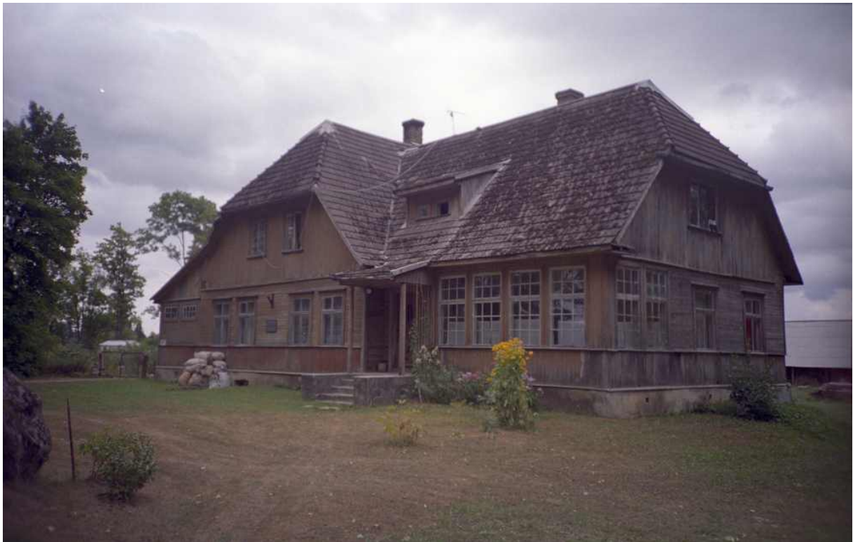
Joonis 4. Palsu talu häärber. Elumajafunktsioon on eraldatud muust talumajapidamisest ( Allikas: www.muis.ee )
