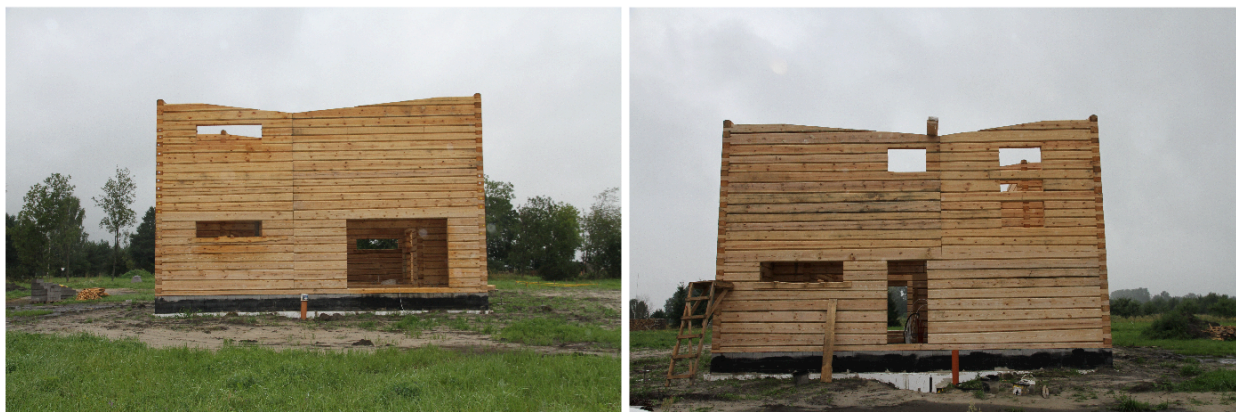
Joonis 47. Saulepa külas asuv kahekorruseline palkhoone. Kogu seinlaualuses kohakuti jätkatud seinapalgid (Foto: Jean-Marie Sevar)
