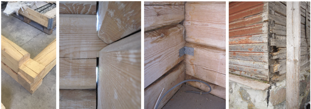
Joonis 35. Hammastappideta kalasabaseotised vajuivad liitest välja varem või hiljem (Foto: Andres Veel)
