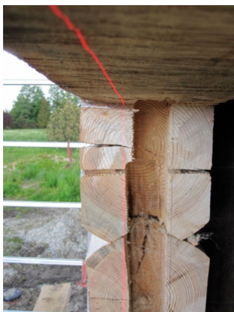
Selliselt olid valmistatud eranditult kõik hoone "tenderpostid"
