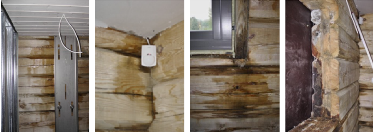
Joonis 8. Sama hoone vihma ajal - voolav vesi tungib hoonesse läbi nurgatappide, tenderpostide ühenduste ja palgijätkude (Foto: Andres Veel)
