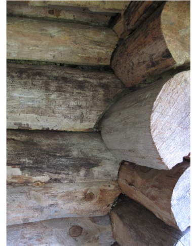
Joonis 36. Koerakaela valmistamise loogika ning tüüpiline, ilmselt igas Eesti külas kohatav, koerakaelaga palkmaja nurkade välisilme (Foto: Andres Veel)
