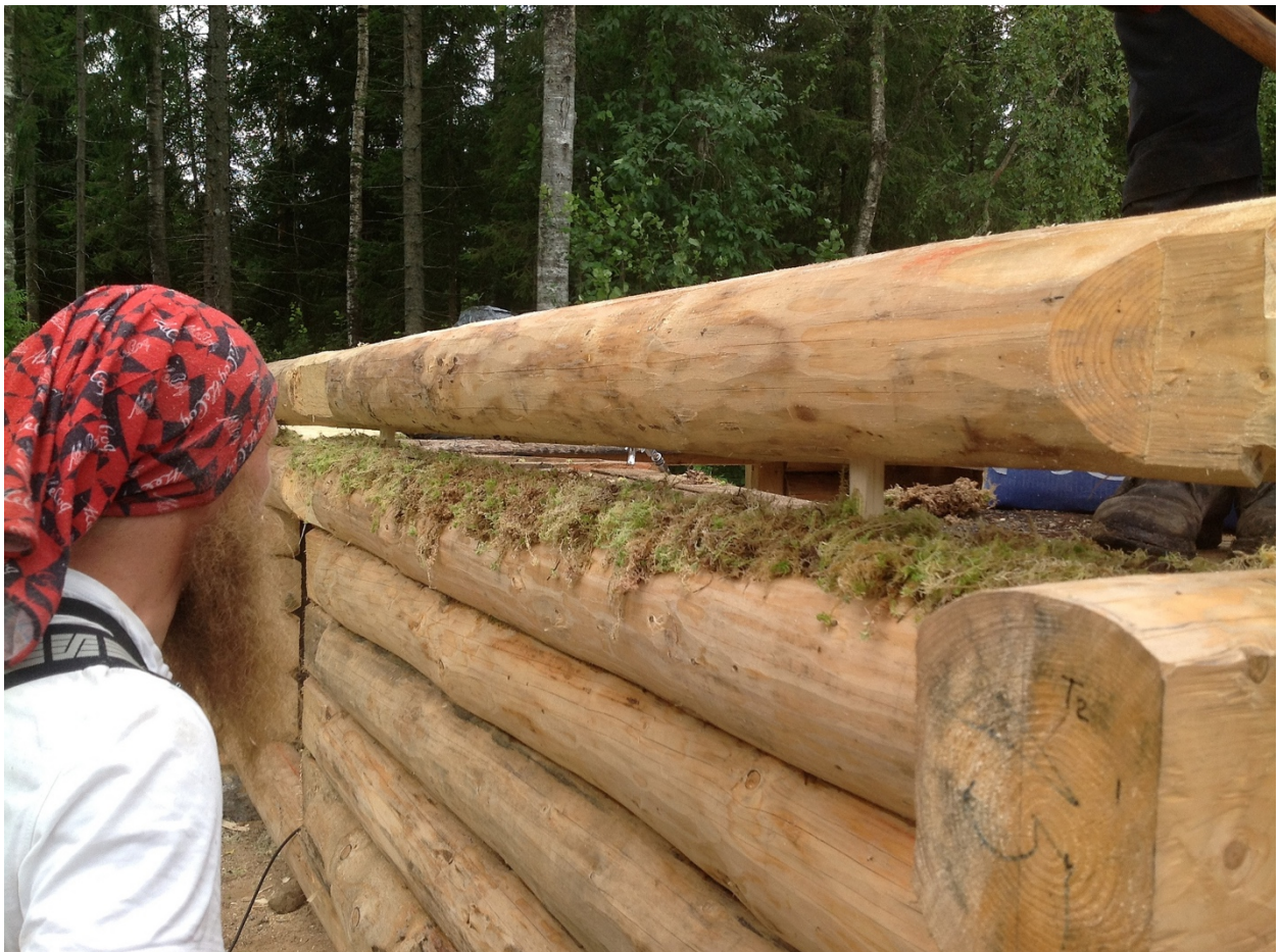
Joonis 40. Sambla kasutamine varaisolatsioonina (Foto: Andres Veel)
