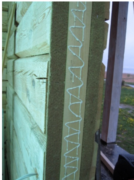
B3 niiskuskindel liim 50 x 75 mm lati ja 50 x 200 mm prussi vahel.
