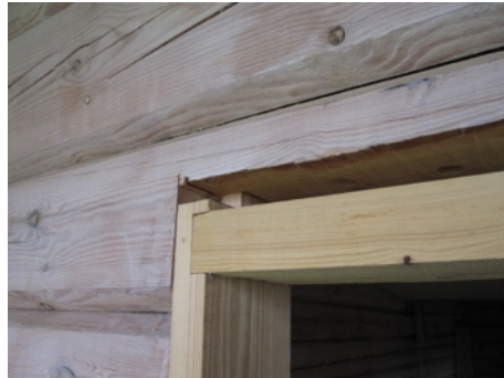
Tenderposti ülemine tapp ja tendreid ühendav silluspruss.
