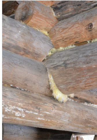
Joonis 36. Koerakaela valmistamise loogika ning tüüpiline, ilmselt igas Eesti külas kohatav, koerakaelaga palkmaja nurkade välisilme (Foto: Andres Veel)
