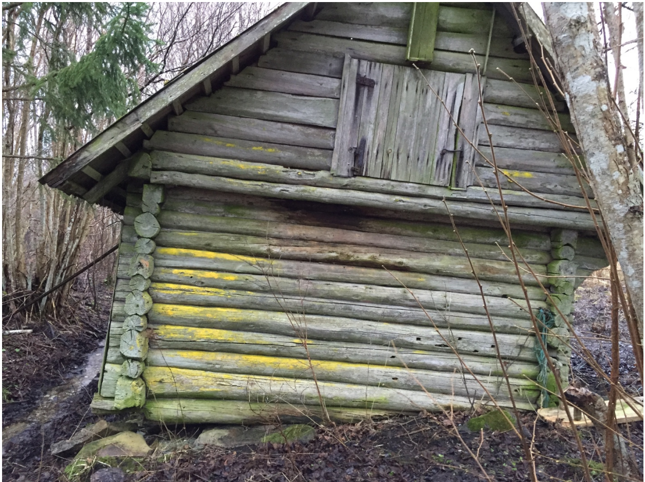
Joonis 46. Ümara pealispinna maakivilt maha vajunud ait (Foto: Andres Veel)
