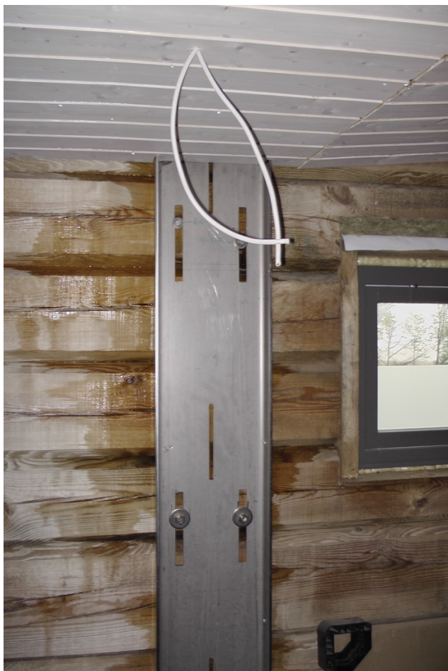
Joonis 48. Saulepa külas asuv kahekorruseline palkhoone. Kohe peale püstitamist hakkasid palkide jätkliited laiali vajuma ning läbi liidete voolas hoonesse sadevesi. Laialivajumise peatamiseks paigaldas tellija vajumist võimaldavad sirutuslatid. Seinte laialivajumine peatus, kuid sadevee sissetung mitte (Foto: Andres Veel)
