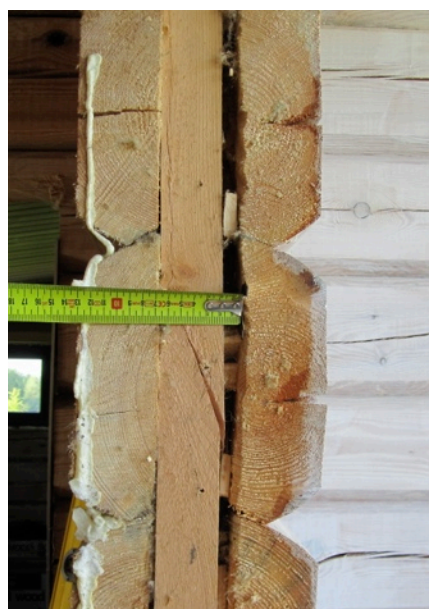
Hoone ehitaja poolt paigaldatud "tenderpost"
