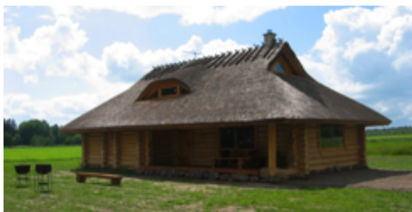
Joonis 6. Hea eestipärase vormi- ja proportsioonitunnetusega hoone (Allikas: www.adamsgrupp.ee )
