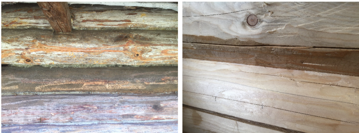
Joonis 29. Vasakul fotol – varahuuled on suures osas avatud ning vara ei ole ilmastikukindel. Paremalt fotol – ideaalselt kontaktne vara. (Foto: Andres Veel)
