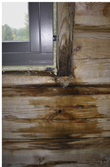
Joonis 55. Saulepa palkmaja. Vesi on tunginud konstruktsiooni ning siseruumidesse mittekontaktsete liitepindade kaudu. Tenderposti alumisse tapipesa tehtud süvenditesse on kogunenud sadevesi millel ei ole olnud võimalik seal välja valguda. Geomeetriliselt ebasobivate tappliide ning erakordselt hooletult teostatud tööde tulemusena vajasid korrigeerimist hoone kõikide avade servad ja vahetamist kõik hoone tenderpostid (Foto: Andres Veel)
