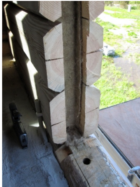
Vildiga tihendatud tapi põhi ja tenderposti fikseeriv tapp aluspalgis.
