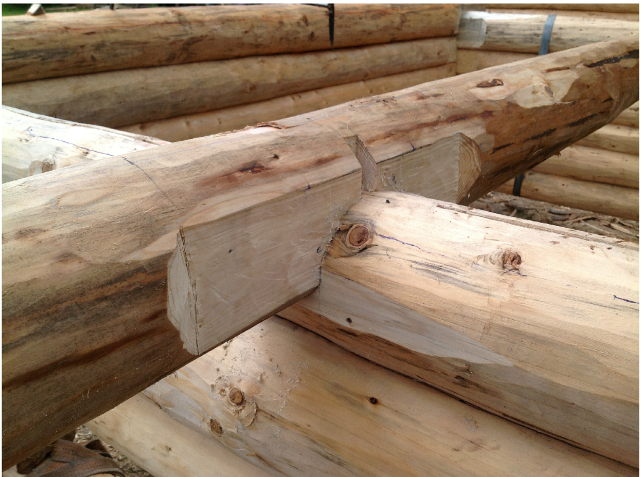
Joonis 62. Ulualuse postidele toetava vahelaetaja ühendus palkseinaga. Sisuliselt pähikuna töötav, palkseinast väljapoole ulatuvasse palki tehtud tapipõsk takistab õhuvoolu läbi liite (Foto: Andres Veel)
