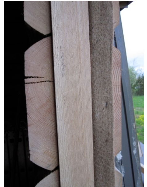
Tihelt pesasse surutud 50 x 75 mm latt koos tihendusvildiga.
