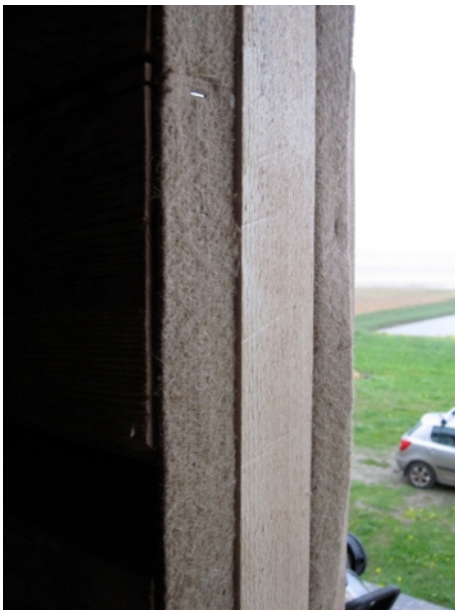
Tenderposti liugtapi pool (latt) koos sisemise ja välimise tihendusvildiga. Välimine vilt on keeratud üle lati külje ja ulatub lati põhja.
