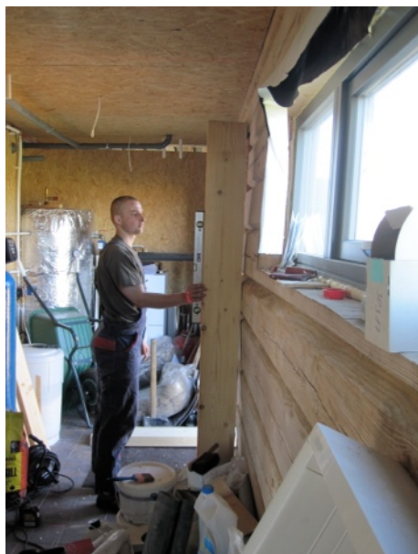
Tenderpostide puudumisest tugevalt välja vajunud sein ukseava kõrval.
