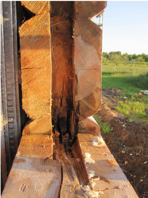
Joonis 54. Tenderposti alumine tappliide. Vasakpoolsel pildil on näha ava allosas olev süvend kuhu koguneb sadevesi millel ei ole võimalik seal hiljem välja valguda. Parempoolsel pildil on näha korrektne tenderposti alumine tappliide – sadevee tungimine konstruktsiooni on takistatud ning välisküljes olev tapipesa on valmistatud selliselt, et oleks tagatud sinna sattunud vee väljavalgumine.
