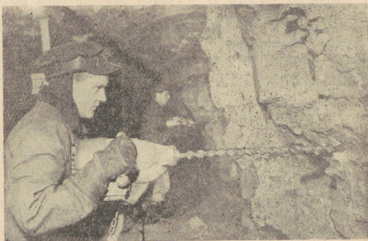
Joon. 32. Töö elektripuuridega põlevkivi kaevandamisel allmaakaevanduses praegusel ajal.
