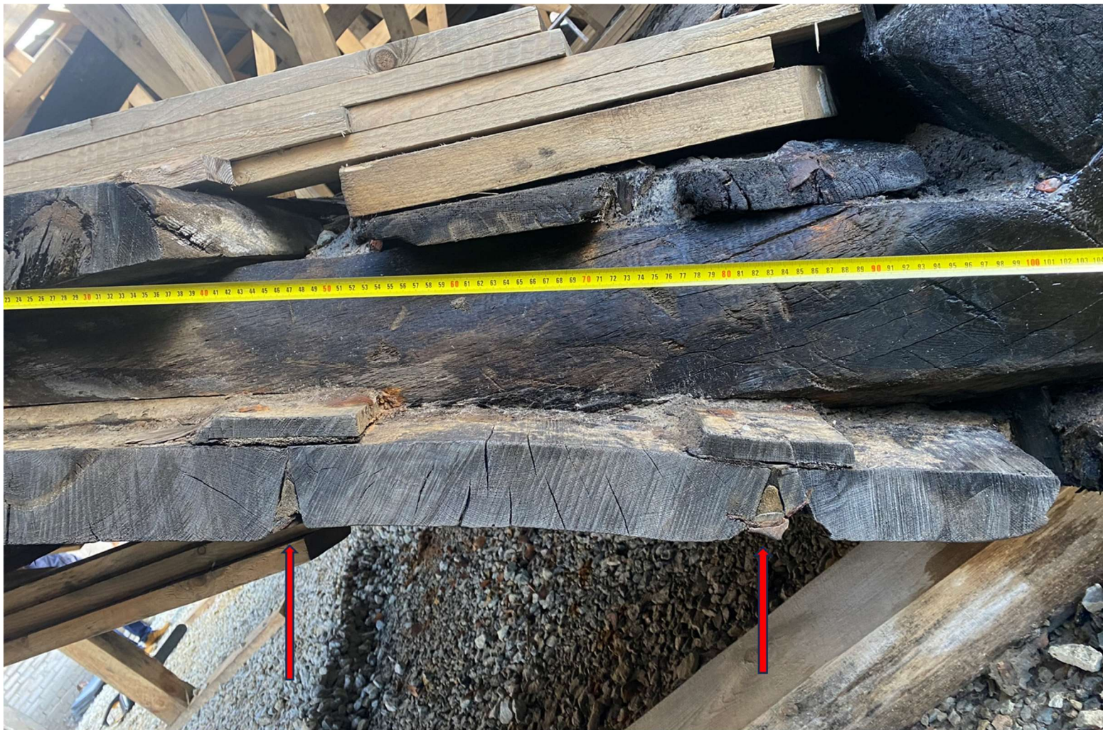
Lisa 4.2. Sileplangutuses põhjaplankude vaheline topend (osundatud punasega) laeva ahtriosas. Näha ka põhjaplankude liitekohti katvad katteplangud.
