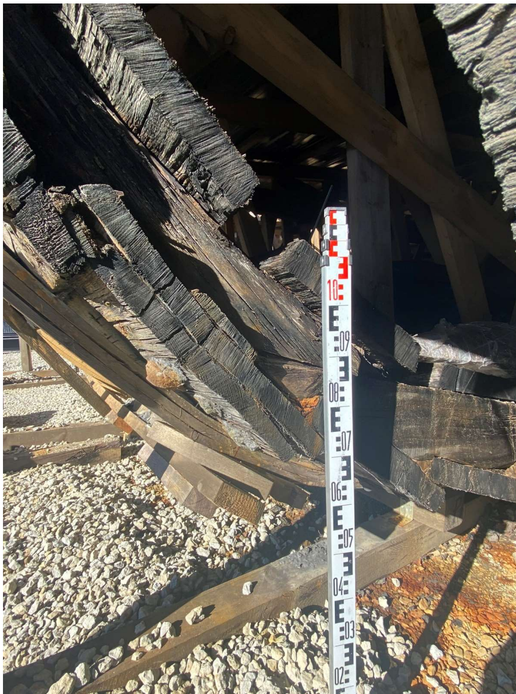
Lisa 3.1. 15.–16. kaare vahelise ristlõike vööripoolne pind. Näha 6. välisplangurea jätkukoht paremas pildis.
