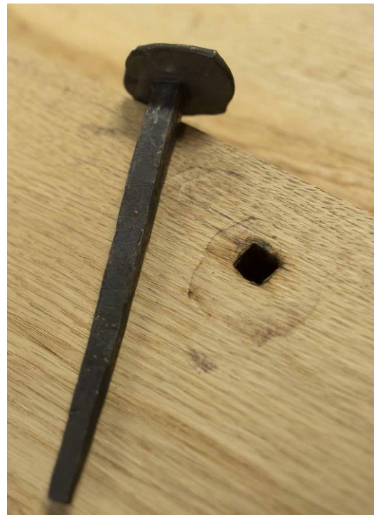
Joonis 10. neljakandiline auk, mille servadest on näha ümaraid puurimise jälgi
