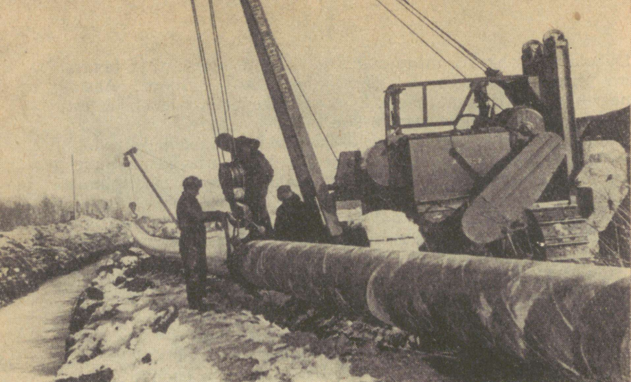
Joon. 92. Kohtla-Järve—Tallinna gaasijuhtme paigaldamine.
