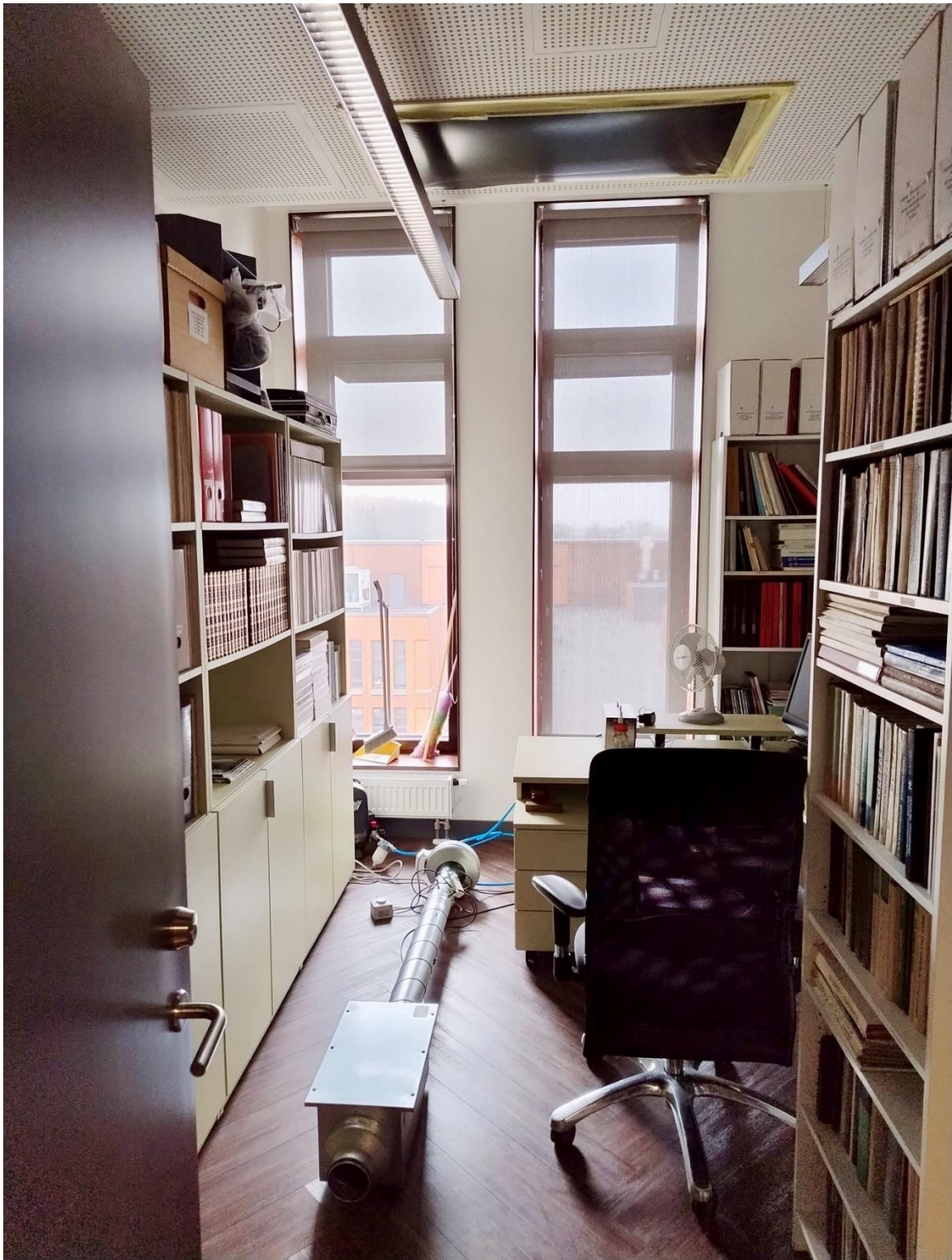
Joonis 4. Kabinet, kust tehti mõõtmisi. Kabineti eraldamine hoone ventilatsioonisüsteemist toimus ventilatsiooniavade katmise näol.
