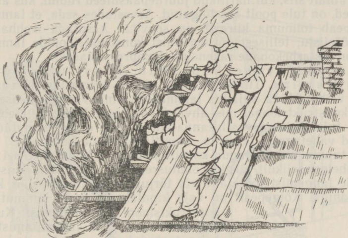
Joon. 57. Katusekatte aluslaudise lammutamine.
