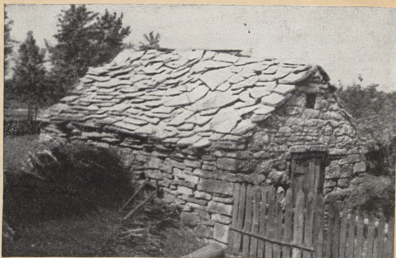
Joon.65. Kiviseinte ja -katusega suveköök. Kaarma, Kiratsi.
