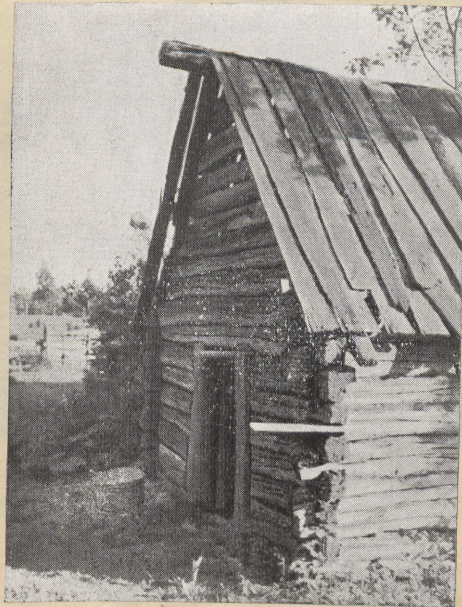
Joon.70. Suev köök, mille katus on laotud kolme-laua- süsteemis. Katuselaudade otsad jooksevad hari- puusse. Kärla, Mätasselja.
