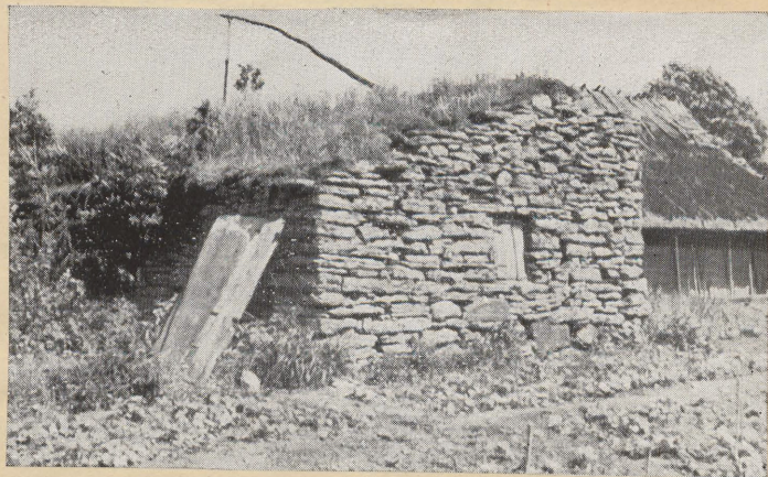
Joon.28. Murdpae tükkidest laotud seinte ja katusega suveköök-sepapaja. Kaarma, Kärdu.
