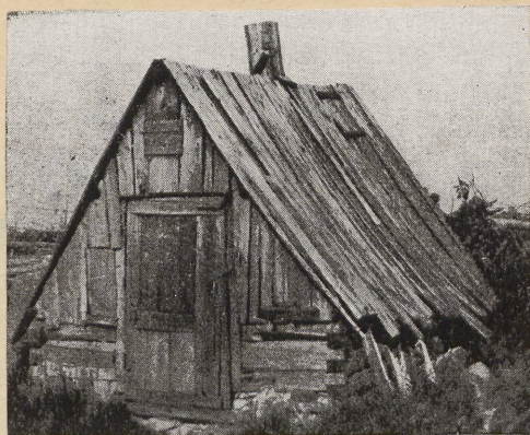
Joon.178. Suveköök, millel on kolm suitsuavaust: auk viiluotsas ja katusel, ning puukorsten harjal. Anseküla, Kõimri.
