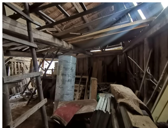
Joonis 4. Vaade konstruktsioonile.
