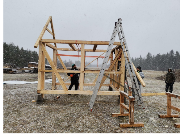
Joonis 39. Sarikate paigaldamine. Samuti on näha, et on alanud lumesadu.
