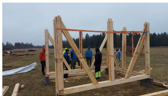
Joonis 37. Fotol on püstitamine täies hoos. Koormarihmasid kasutasime, et tõmmata detaile omavahel kokku.
