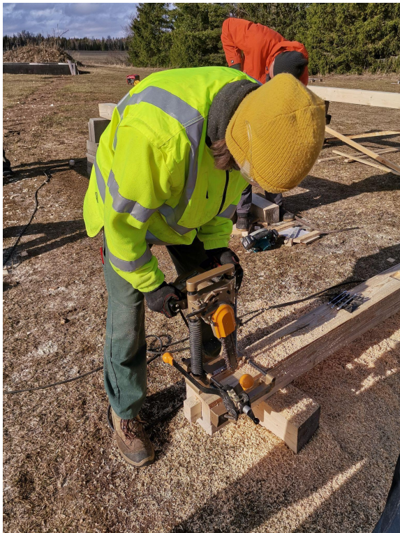
Joonis 31. Koolitusel osaleja kasutamas Makita tapifreesi.
