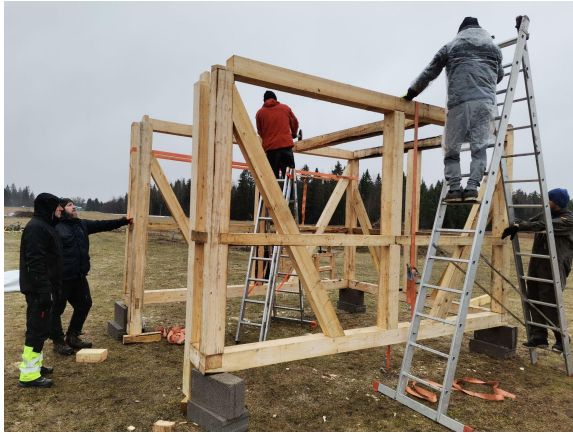
Joonis 38. Redelite kasutamine ülemiste detailide paigaldamisel.
