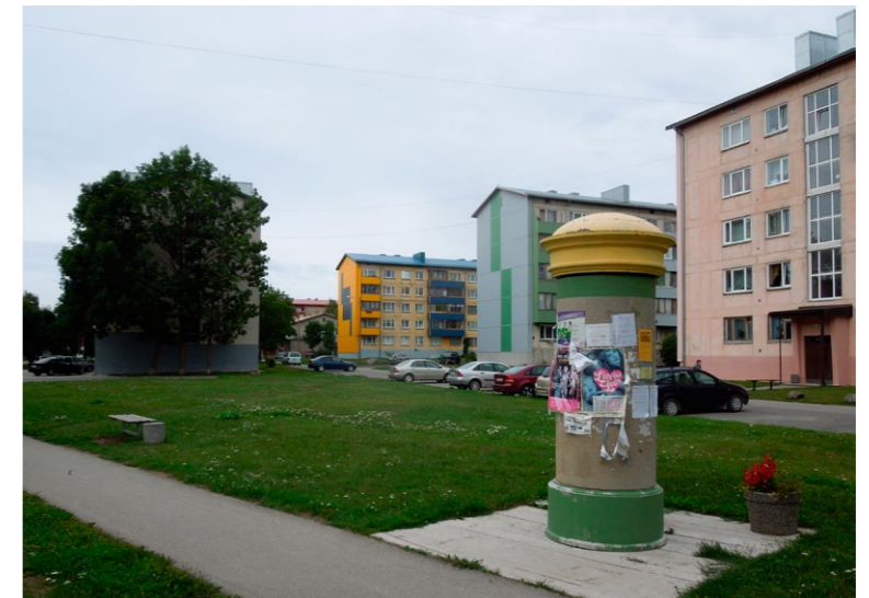
Joonis 10.3. Paldiski on jätkanud ka pärast ühiskonnakorra muutust suuresti militaarlinnana. Linnakeskkond, 1970ndate hoonestus on muutunud värvilisemaks, ot-saseinu on renoveeritud, soojustatud. Linnamiljööd loob sotsialismiaegne kuulutustesammas.
