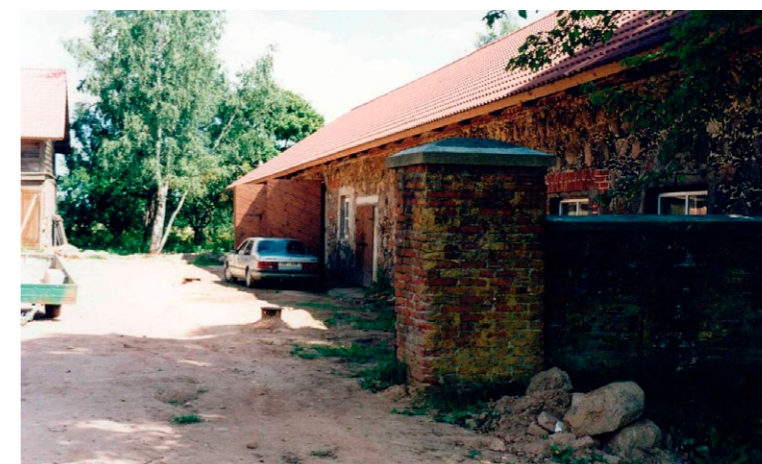
Joonis 22.1. Postijaama tall enne renoveerimist (suvi 2003).
