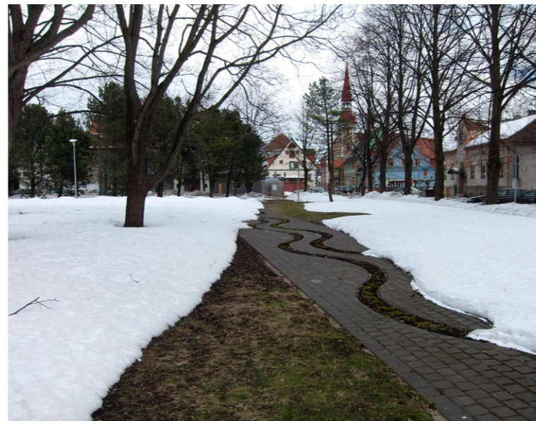
Joonis 8.13. Kes arvutab välja soojustrasside küttekaod? Talv 2011 Pärnus Valli pargis.
