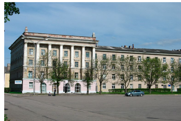
Joonis 10.4. Stalinistlik-neoklassitsistlik hoone Keskallee 17 Kohtla-Järve endise sotsialistlikuks nimetatud linnaosa peaväljakul. Lengorstroiprojektis planeeritud terviklik linnaplaan, ranged ruumisümmeetriad, stalinistlik monumentaalsus ja stiilipuhas arhitektuur kannavad tänini edasi Kohtla-Järve kui sotsialistliku linna tunnuseid.
