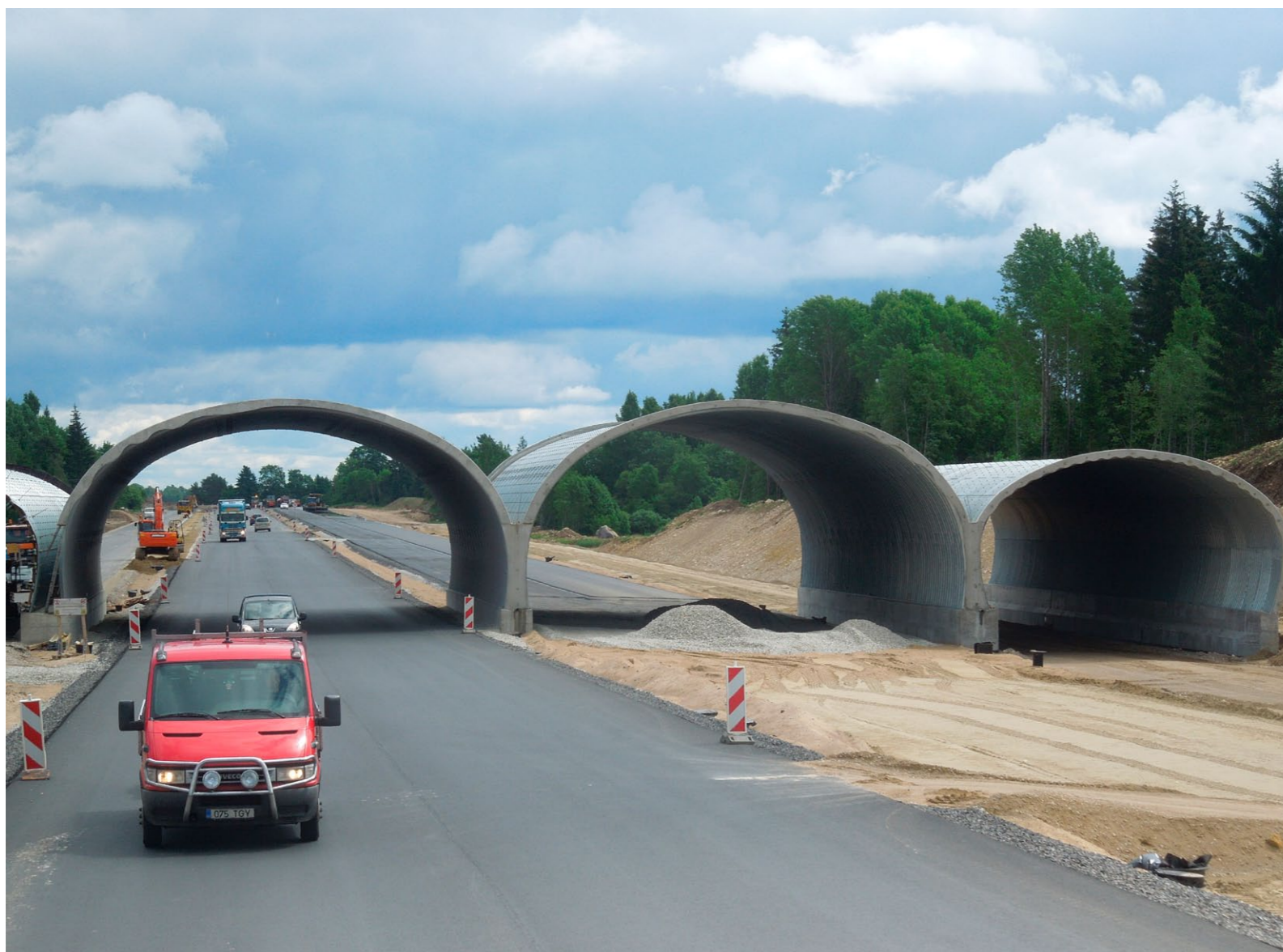
Joonis 16.5. Tallinna-Tartu maantee Aruvalla-Kose lõigul Kolu lähistel valmib 2013 lõpuks Eesti esimene ökodukt. See looduslike tunnustega tehnorajatis tõstab eri tasanditele kiirtee ja rohetaristu ning hoiab ära rohevõrgustiku katkemise. Kolu loomasild on eelkõige vajalik põtrade sesoonseks rändeks põhjapoolsetelt talvistelt toitealadelt suviste toitealadele Kesk-Eesti soodes.
