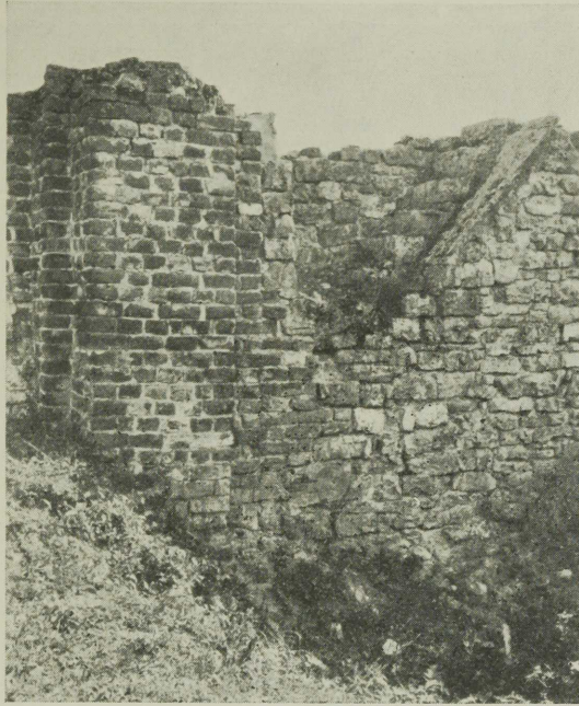
Abb. 24. Turmtreppe in der Kirchenruine zu Holme. Photo T u l s e.
