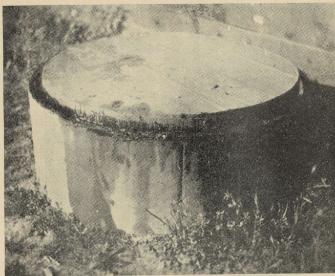
Pilt 11. Tsemendist kaevuraketest õlirenn — kaanega silohoidla.
