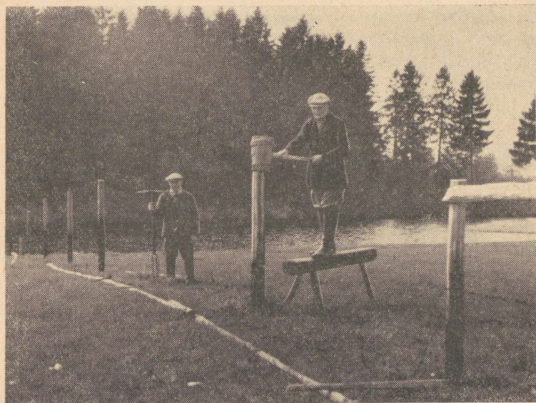
Joonis 6. Koplitarade püstitamine.
