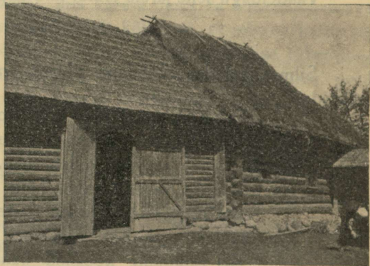
Pilt 12. KONDRA TALU REHETUBA ja rehealune väljastpoolt. Obinitsa kl. Paremases ääres näha väravakatuse ots. Rehetoa hoovipool- ses seinas väike aken ja paja.
