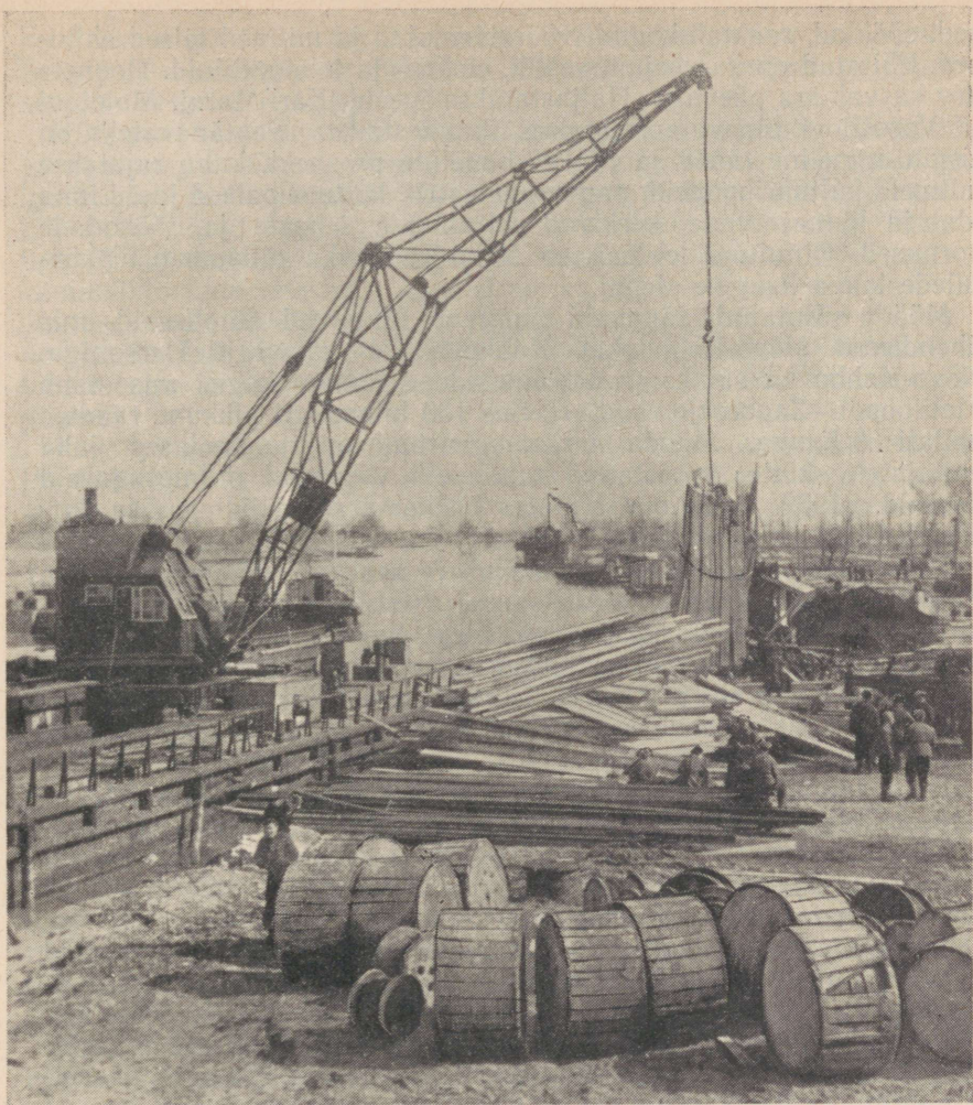
Kahhovka hüdrovälme ehitustöödel. Pildil: Novo-Kahhovka sadamasse saabub ehitusmaterjali.
