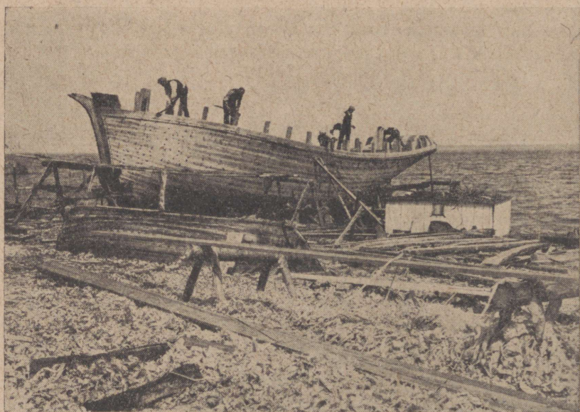
Рис. 63. Постройка корпуса парусного суда. Вправо — изготовленная отдельно каюта.
