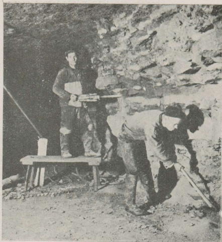
1. joonis. Puurimistööd põlevkivi allmaakaevanduses. P. Üksküla foto.
