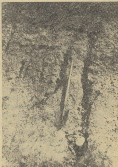
Foto 1. Pinnavee toimel tekkinud kraavinõlva erosioon.
