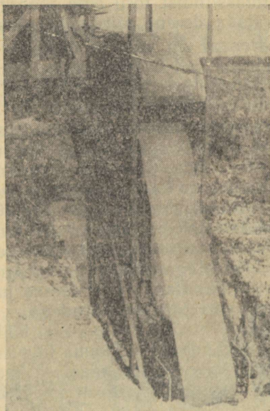
Joonis 2. Plastmass-torudreeni ehitamise katsestend.
