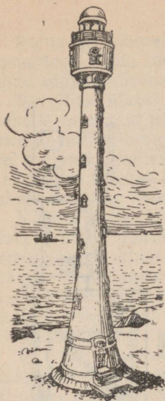
Joonis 40. Raudbetoonist tuletorn.
