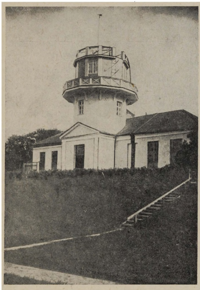
Рис. 6. Вид обсерватории с северной стороны.
