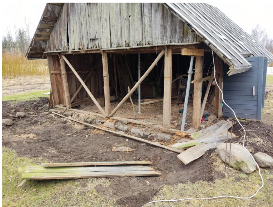
Joonis 11. Hoone renoveeritava osa laudise eemaldamine (Joonis: J. Voll)
