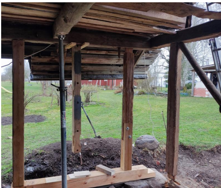
Joonis 19. Mõõtmisel ja arvestamisel tehtud viga, millest tõttu sai liiga pikk post (Joonis: J. Voll)
