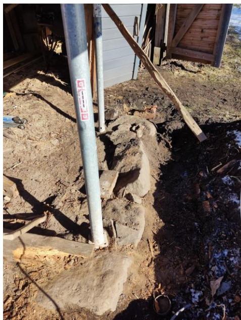
Joonis 12. Lõunapoolse külje vundamendi osa puhastamine (Joonis: J. Voll)
