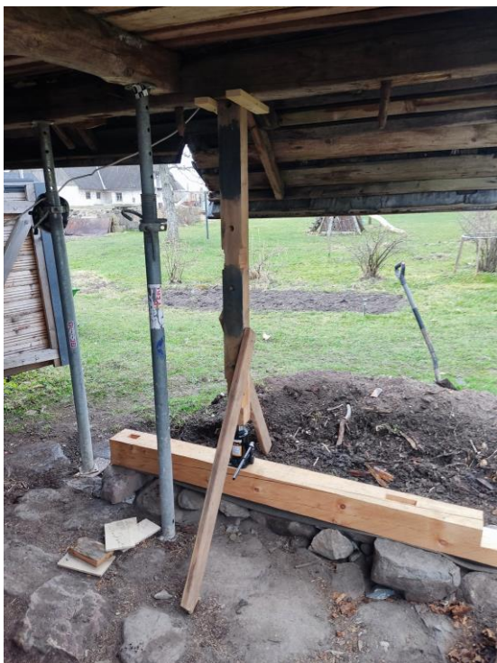
Joonis 18. Tungraua ja peri-postidega hoone tõstmine (Joonis: J. Voll)
