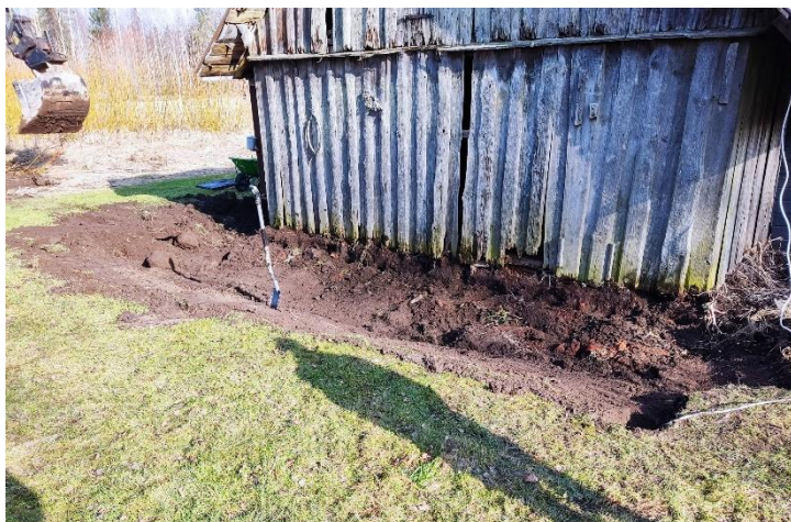
Joonis 10. Ekskavaatori ja laidaga pinnase eemaldamine vundamendi äärest (Joonis: J. Voll)
