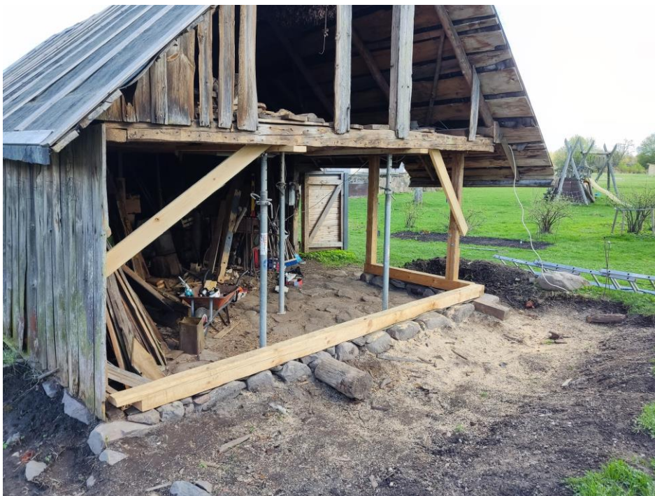
Joonis 24. Otsa seina alumise raampuu sobitamine vundamendile (Joonis: J. Voll)
