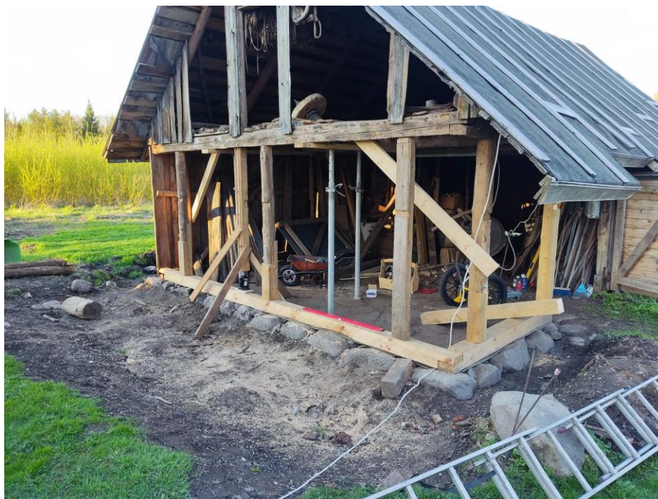
Joonis 25. Otsaseina uue alumise raampuu ja postide paigaldamine tungrauaga (Joonis: J. Voll)
