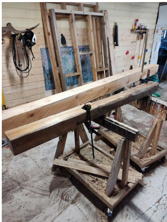
Joonis 16. Posti proteesimine (Joonis: J. Voll)
