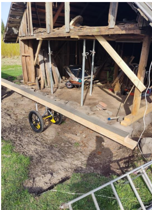
Joonis 23. Alumise raampuu transport palgikäruga (Joonis: J. Voll)
