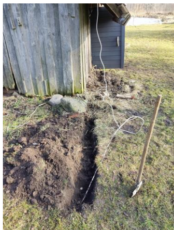
Joonis 9. Elektri kaabli väljakaevamine
