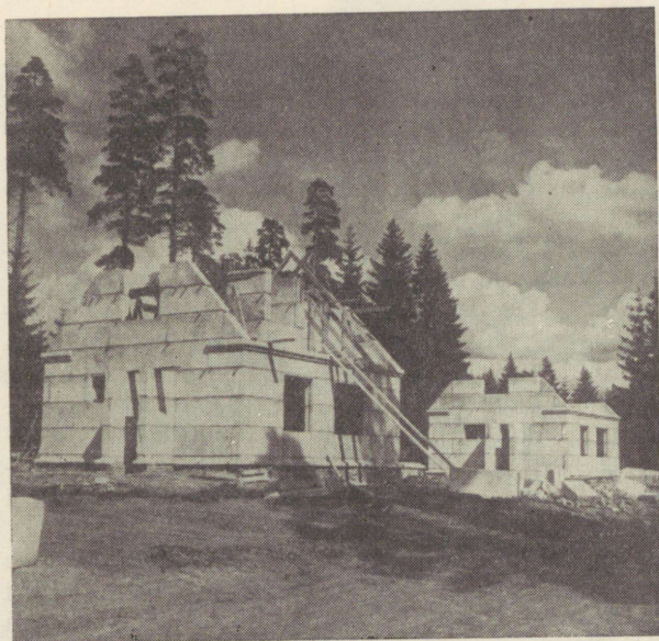
Aegviidu ehitab. Silikaltsiitplokkidest maju raadio- releeliini vahejaama töötajatele
