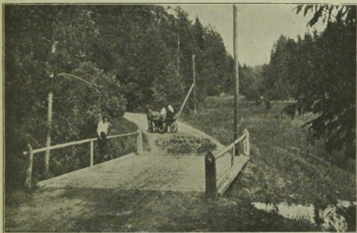
Brücke über die Mor-upe bei Oger auf der Strasse nach Turkalu.
