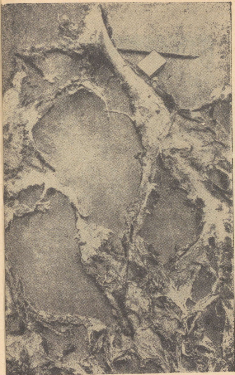
Joon. 9. Merulius lacrymans (päris-majaseen). Tuhkjashall kile ja kuivanud paelmoodustised. Võetud keldrikorruse laelt.
