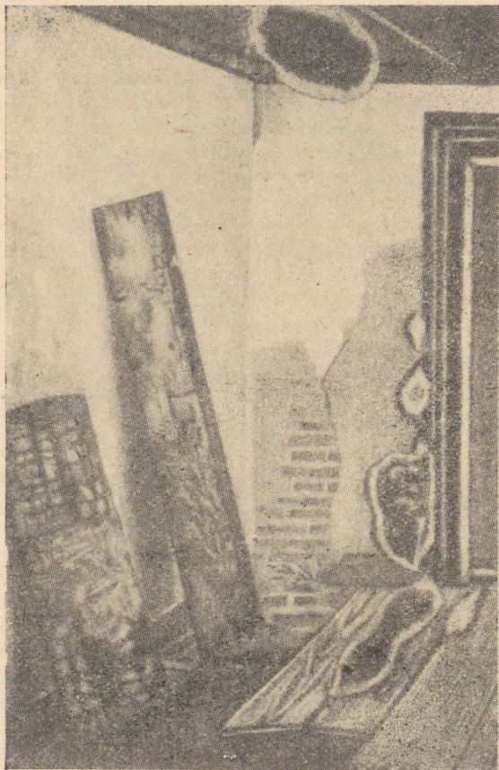
Joon. 8. Päriss-majaseene hävitustöö ehituselementide kallal.
