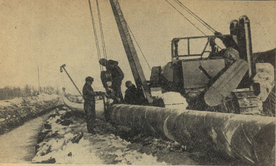
Рис. 92. Установка газового трубопровода Кохтла-Ярве — Таллин.
