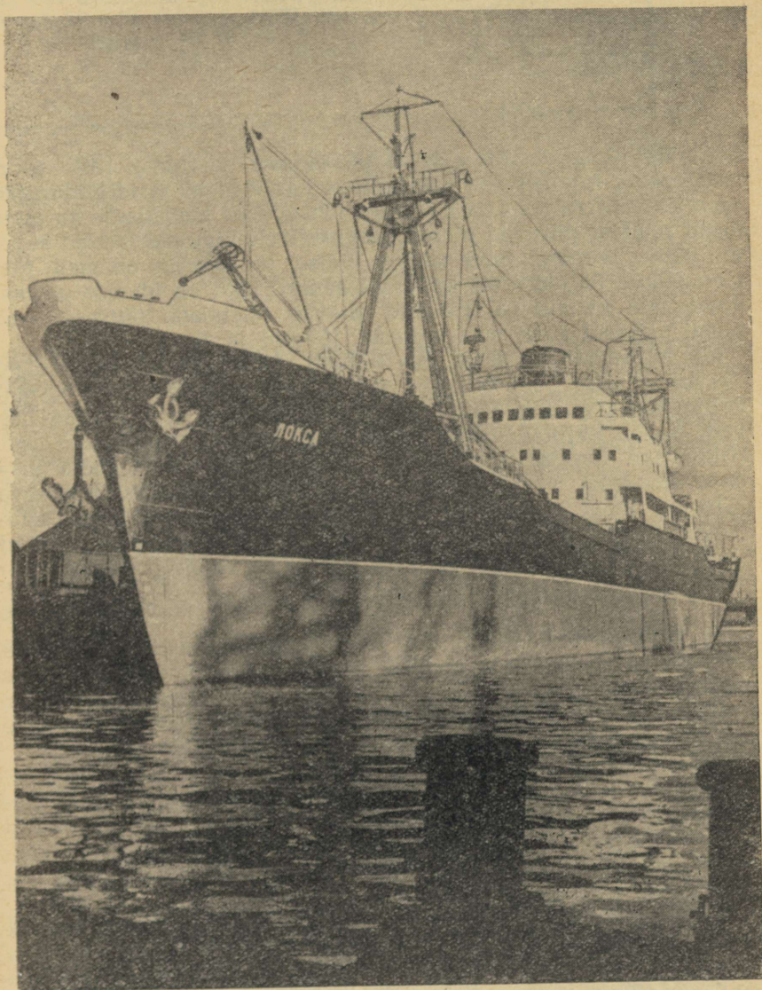
Joon. 153. Mootorlaev «Loksa». Kuni süvisejooneni on laev värvitud ühte värvi, altpoolt süvisejoont aga teist värvi (harilikult punaseks).
