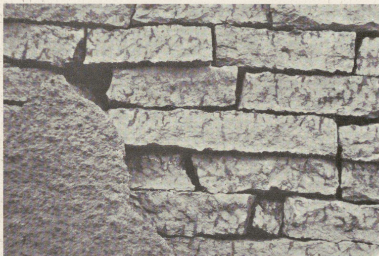
Taf. III, Abb. 2. Stapel von gebrochenem Kalkstein der Baukalksteinzone im Lügänu'schen Steinbruch. Die eisenoxydhaltigen vertikal gerichteten Adern sind als dunklere Streifen sichtbar. Verkleinerung 30 ×.
