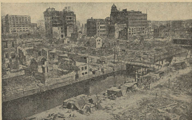
33. joonis. Tokio pärast 1923. a. maavärinat. Pange tähele rusuhunnikuid ja purunenud ning viltuvajunud raudbetoonist „pilvelõhkujaid“!
