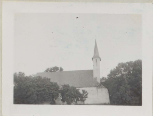
Vaade kirikule põhjapoolt. Paremal kiriku otsas on näha märiline torni tugiõelant
