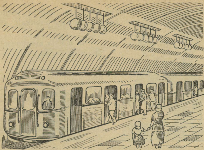
Joon. 139. Elektrirong metroos.
