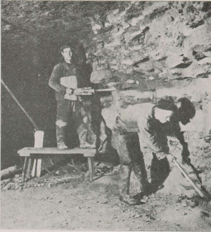
1. joonis. Puurimistööd põlevkivi allmaakaevanduses. P. Üksküla foto.
