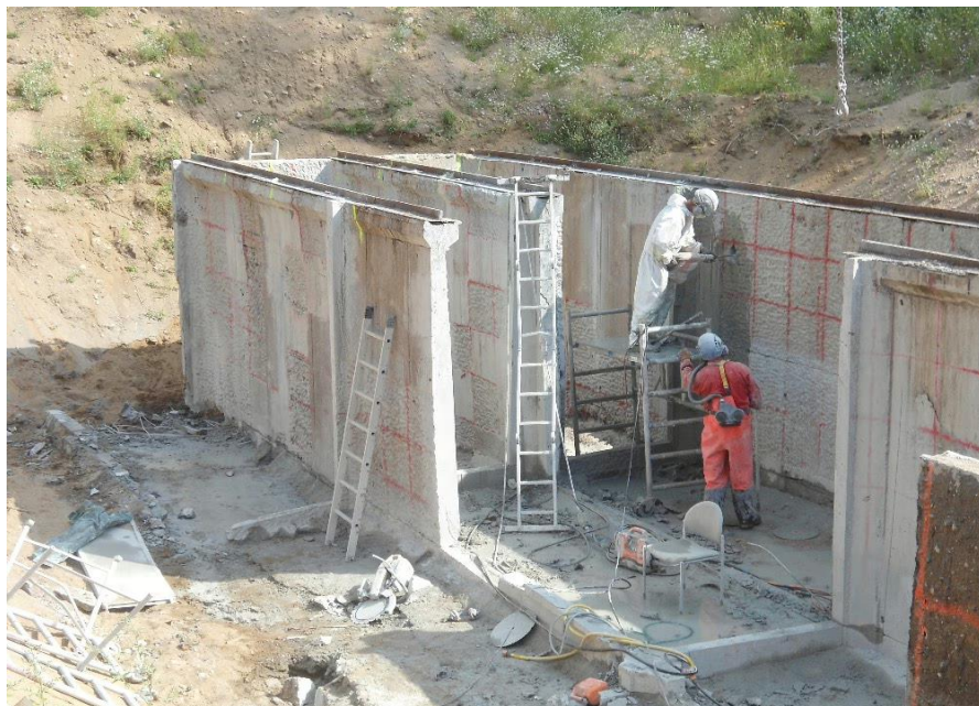
Lisa 3. Foto Tammiku radioaktiivsete jäätmete hoidla dekomissioneerimisel seinaproovide võtmisest. (ALARA, i.a)
