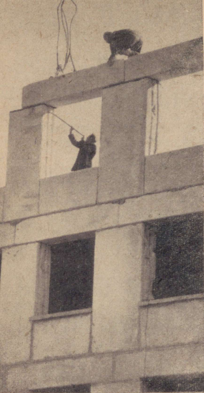
Joonis 4. Silikaltsiitmajade püstitamine.
