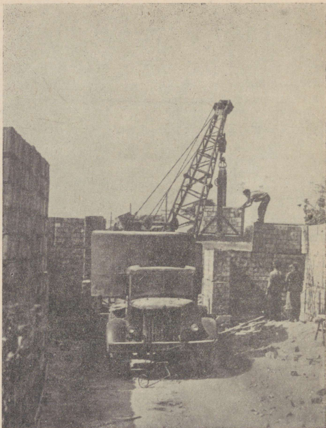
Joonis 25. Silokraavi montaaž tellisplokkidest autokraana abil.
