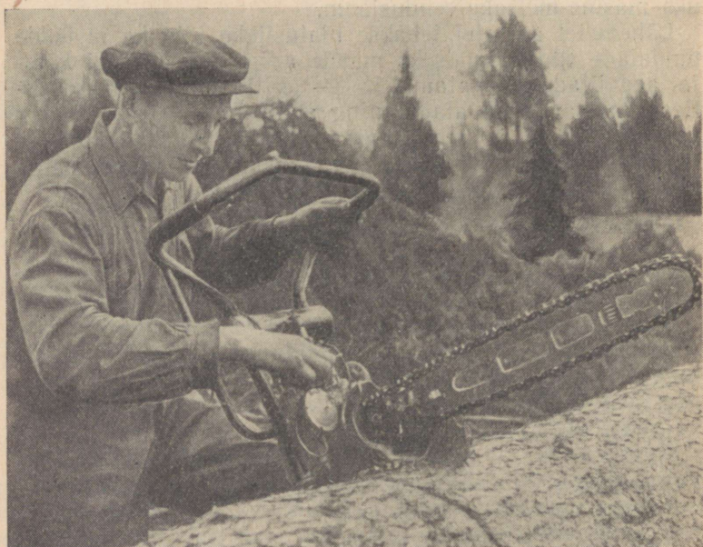
Puude langetamine bensiinimootorsaega Tudu metsapunktis.
