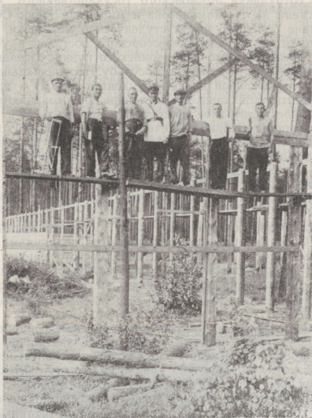
На строительстве конюшни
