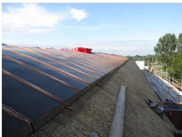
Foto 15 Vasest hari kuplikujulisel roogkatusel (Vakfederatie Rietdekkers, 2023a)
