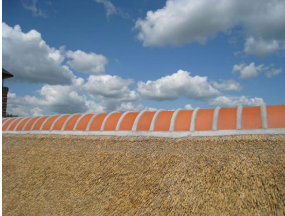
Foto 17 Hollandis levinud poolkaarekujulistest keraamilistest kividest katusehari. Kivid kestavad küll katuse eluea, kuid vuugid võivad ilmastikus praguneda. (Vakfederatie Rietdekkers, 2023a)
