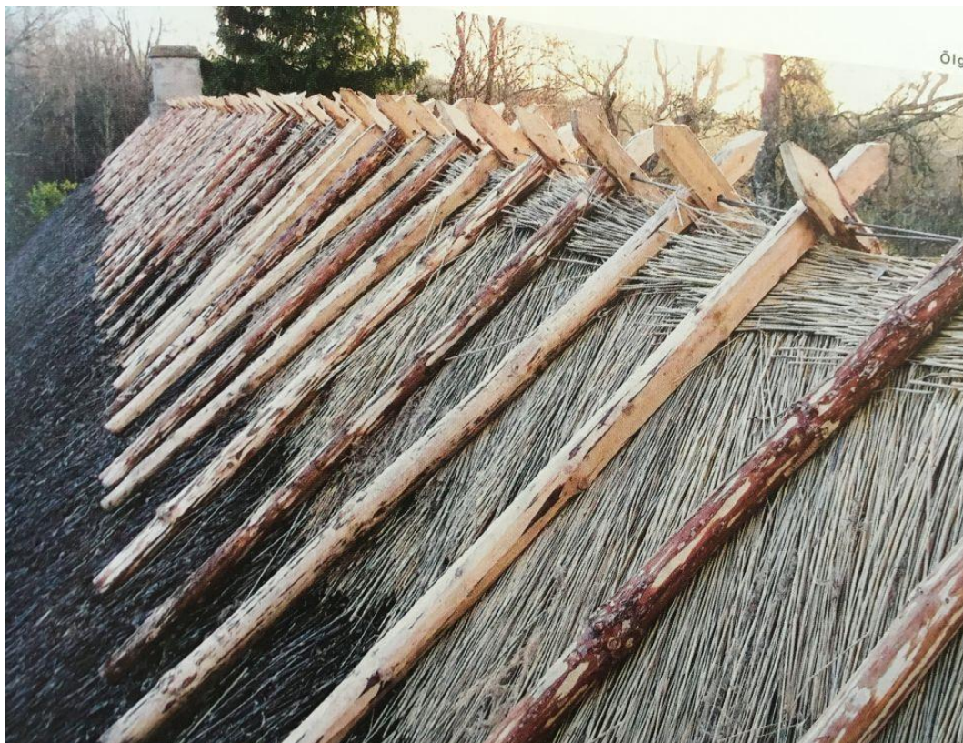
Foto 12 Harjaroo on asetatud diagonaali, et need juhiks suurema vee harjast katusepinnale (foto: Siim Sooster)
