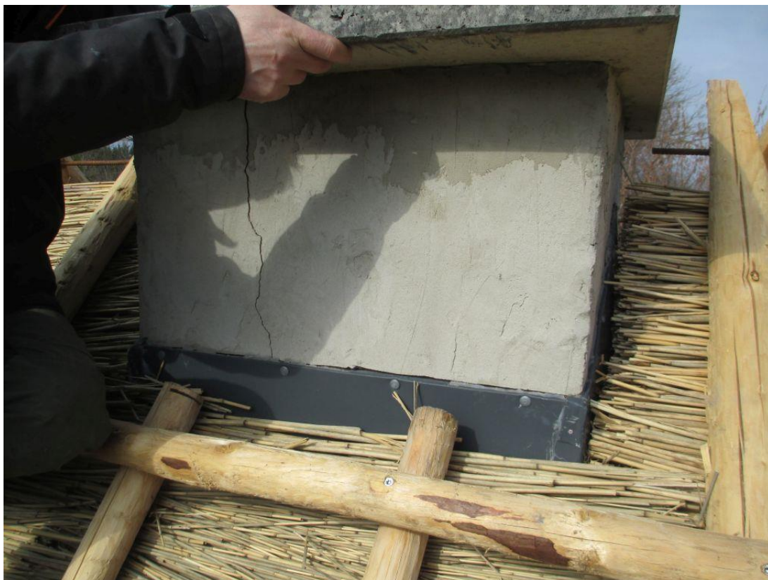
Foto 10 Fibo plokiga vooderdatud telliskorstna läbiviik, viimistlus plekk ja krohv, peal dolokivist pits (töö autori foto)
