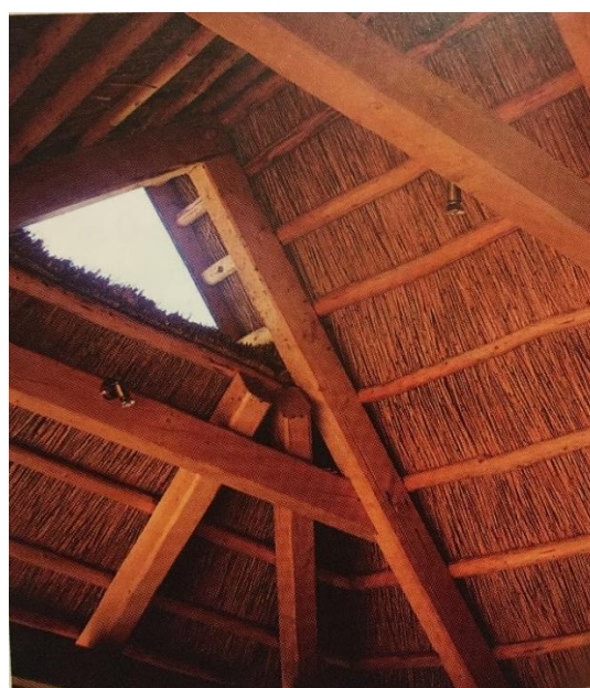
Foto 2 Rooaluspuistega lahtine konstruktsioon, pikk ilma õiteta roog on ühtlase kihina katuse ehitamisel alla laotatud. (foto: Siim Sooster)
