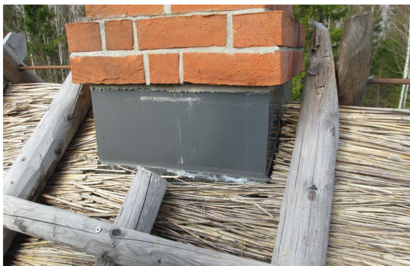
Foto 9 Tuletõkkevilla ja plekiga kaetud Isokern korstna läbiviik, peal tellistest laotud pits. (Töö autori foto)
