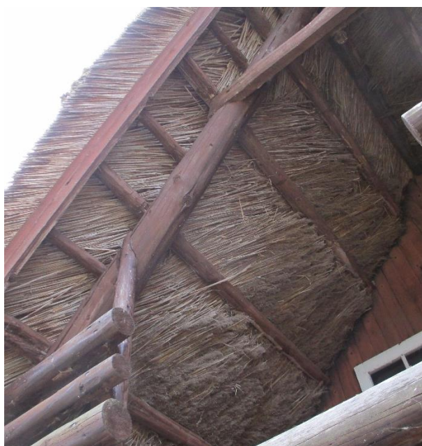
Foto 1 Lahtine konstruktsioon ilma rooipusteta, kergesti süttivad rooõied paistavad. (foto: töö autor)
