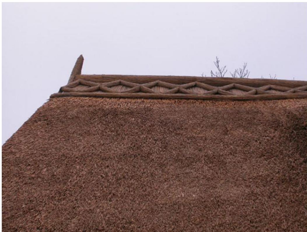
Foto 19 Näide Hollandi õmmeldud ja dekoreeritud katuseharjast. Näeb hea välja, aga kestab kõigest 5-8 aastat (Vakfederatie Rietdekkers, 2023a)
