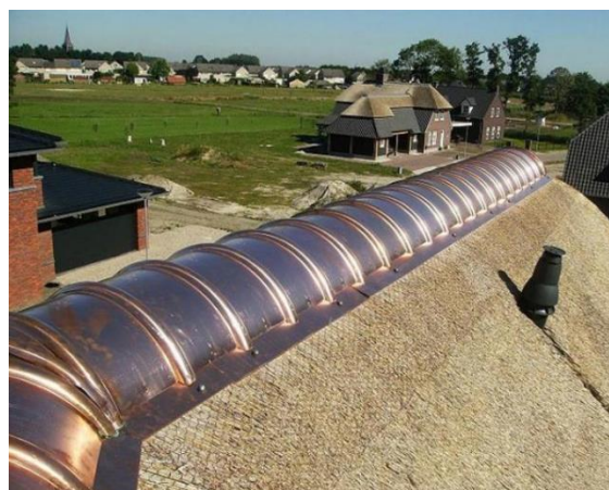
Foto 16 Vasest hari viilkatusel. Selline vaskhari on taaskasutatav ja kestab mitme katuse eluea. (Vakfederatie Rietdekkers, 2023a)
