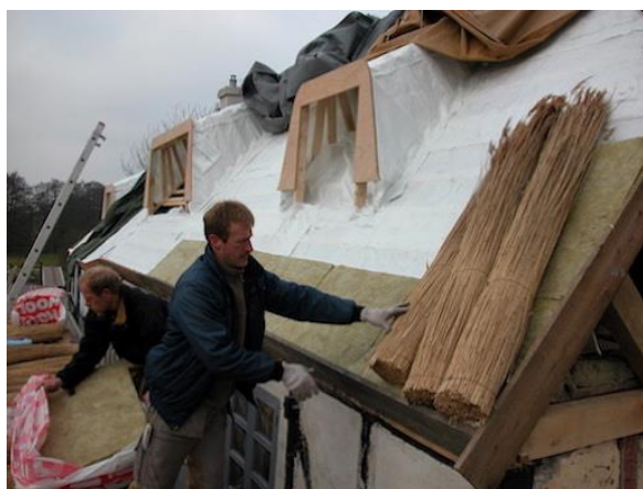
Foto 6 Sepatec tuleohutussüsteem näeb ette kogu katuse katmist klaaskiudkangaga ja perimeetri ja kriitiliste sõlmede katmist pehme mineraalvillaga (Christensen, 2003)
