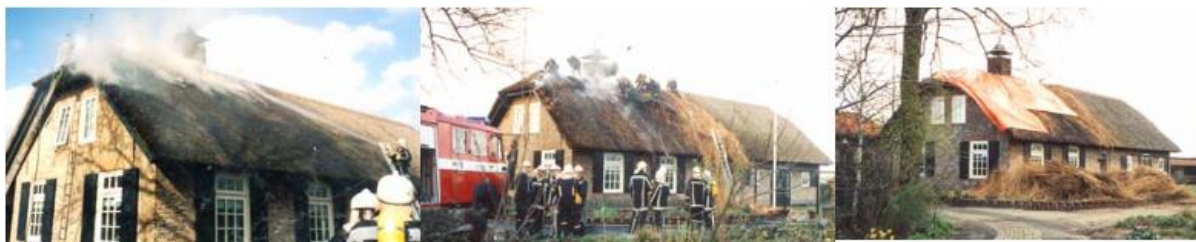
Foto 5 Pragunenud korstnast süttinud kruvikatusega talumaja (Vakfederatie Rietdekkers, 2004)
