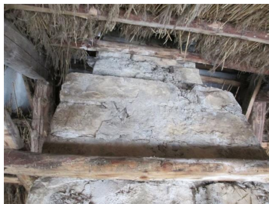
Foto 8 Näide vanast korstnast. Roogkatusele on küll peale paigaldatud eterniit, kuid fotolt saab aimu, kuidas vanasti korstnate tuleohutusele suurt rõhku ei pööratud. (töö autori foto)
