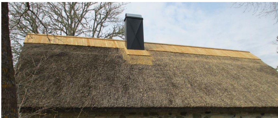
Foto 13 Lühikeste laudadega kaetud hari. Korsten on saanud endale ümber täispleki (töö autori foto)
