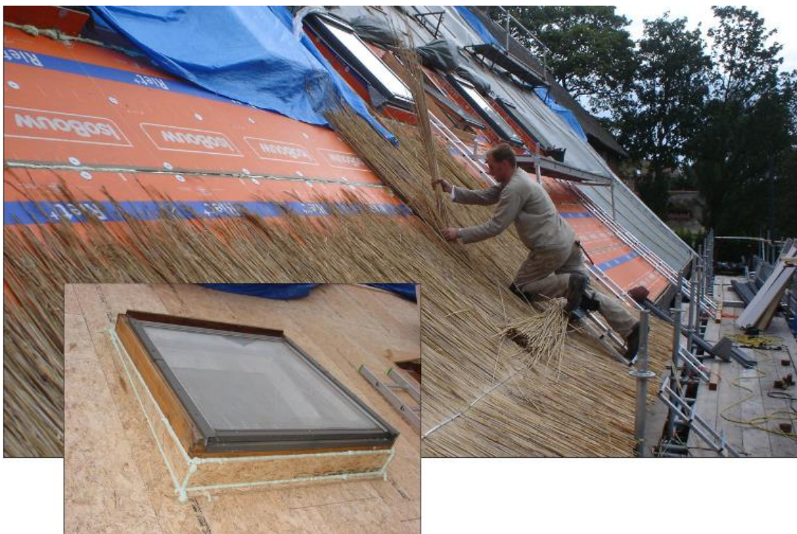
Foto 3 Kinnine aluskonstruktsioon: roog paigaldatakse otse plaatmaterjalile (OSB või näiteks IsoBouw Riet) (Adviesburo Nieman B.V. EMAD Consultancies B.V. et al., 2009)
