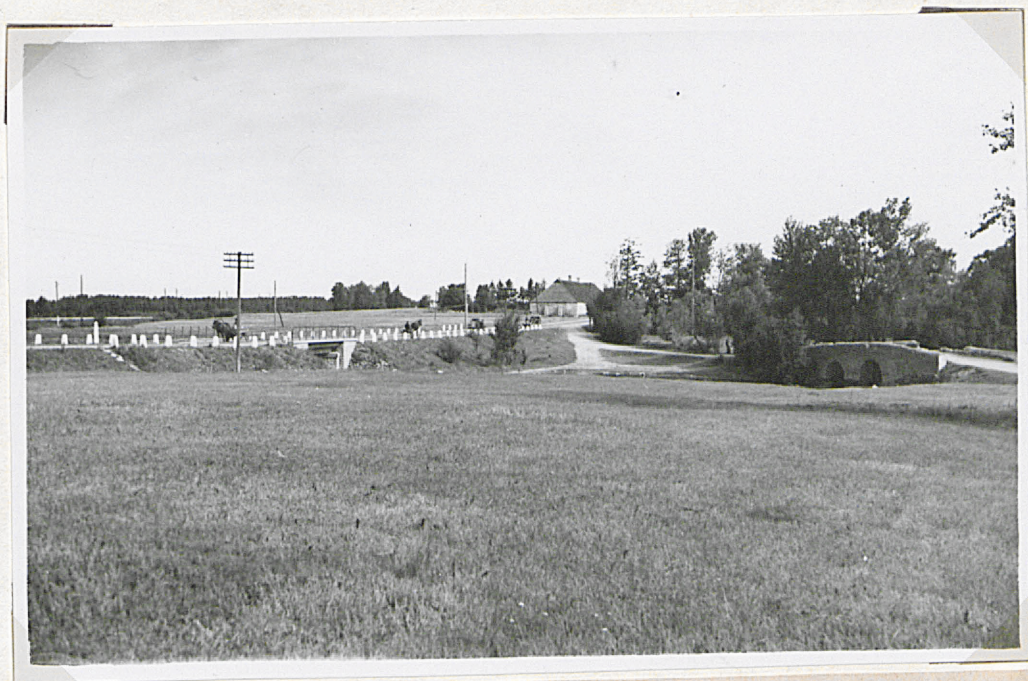
123. Pääsküla sillakoht ("Furt"). Paremalt vana, vasakul uus Tallinn-Pärnu magistraal-maantee ning raudtee, vahepeal läbisõidukoht jõest. Kaugemal end. Pääsküla trahter. (Autori foto 3.VIII 47.)
