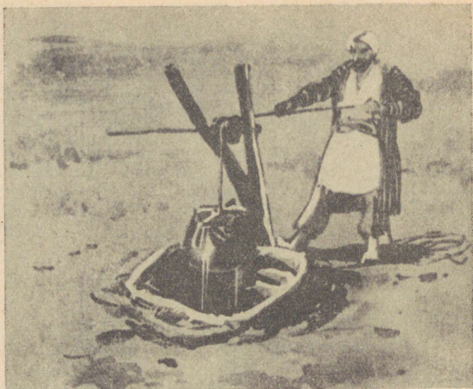
Joon. 26. Muistne kaev kõrbes. Kaevu toestik on tehtud saksaulist. „Ämber“ tehti seremettnahast, et mitte lõhkuda kaevu põhjas savikihti, mille all asetseb soolane vesi.
