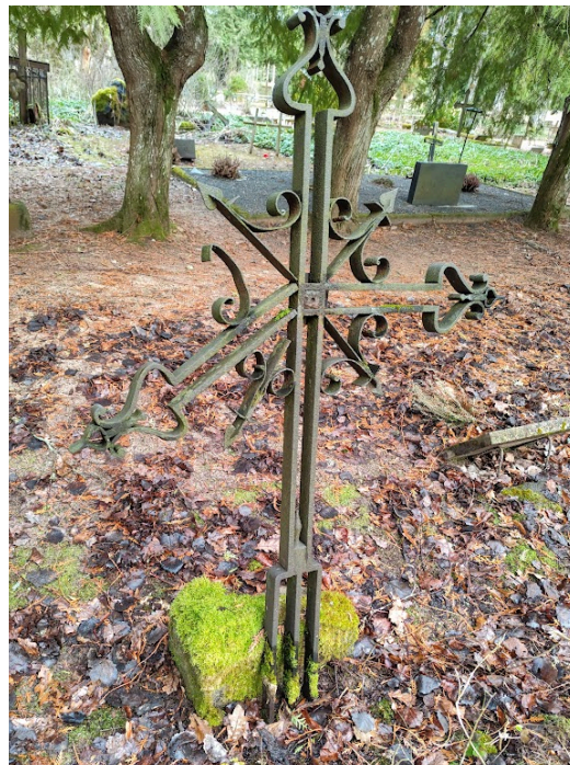
Joonis 11. Mehaanilise vigastusega sepisrist (autori foto).
