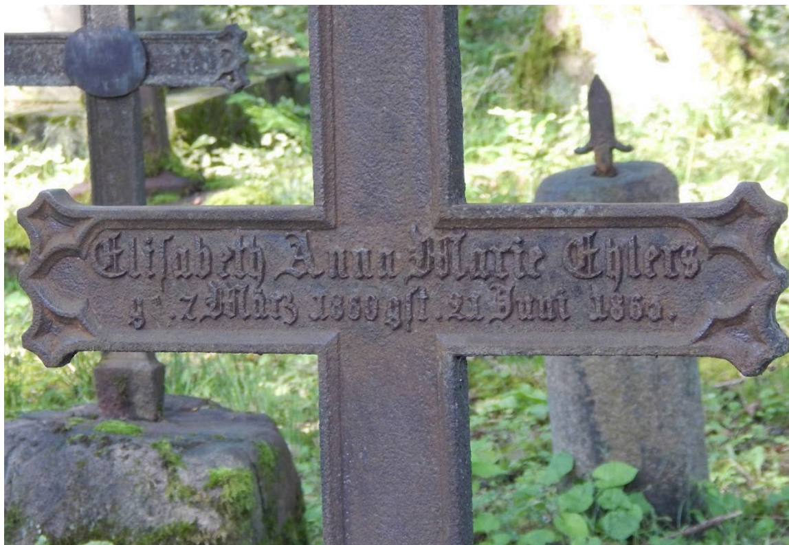
Joonis 3. Malmrist peale inhibiitoriga katmist (autori foto).
