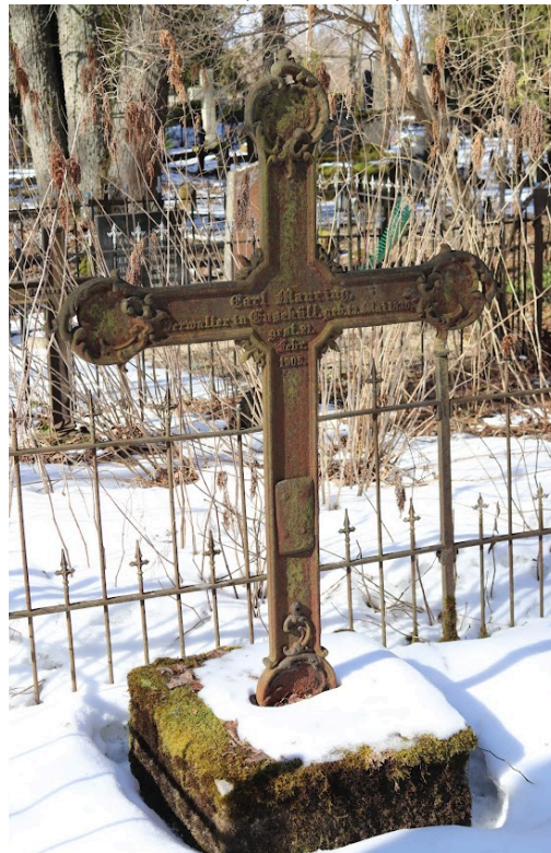
Joonis 15. Lapiga parandatud malmrist Paistu kalmistul (autori foto).
