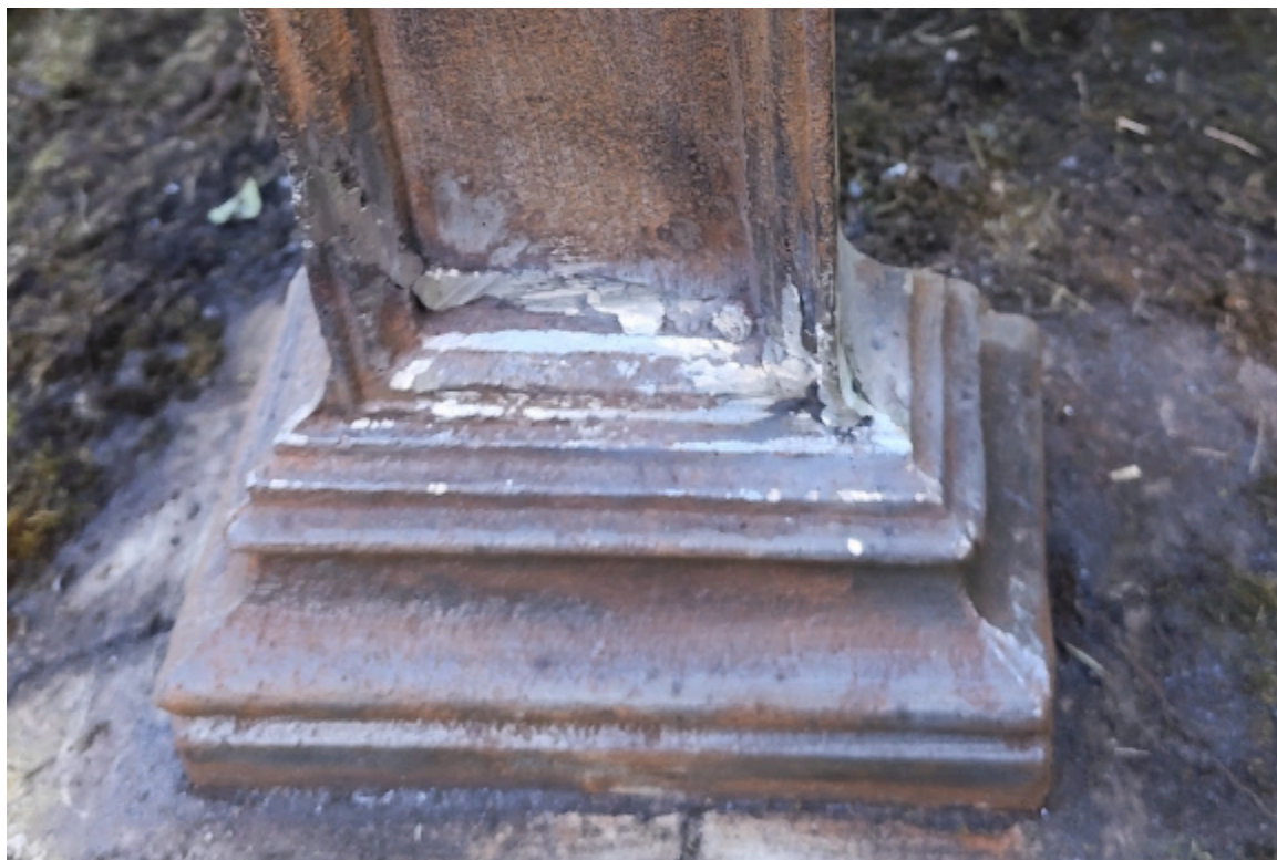
Joonis 10. Mõlema poole kantide servad on “ehitatud” (autori foto)
