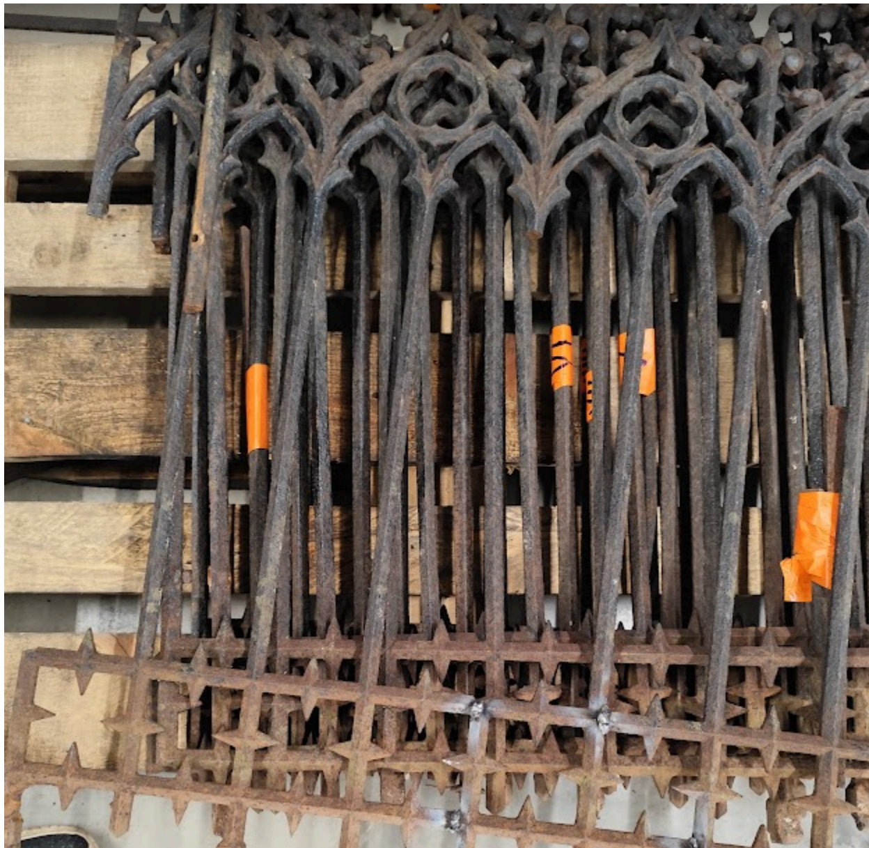
Joonis 15. Hulgi vigastustega aiapaneel Viljandi Vanalt kalmistult (autori foto).
