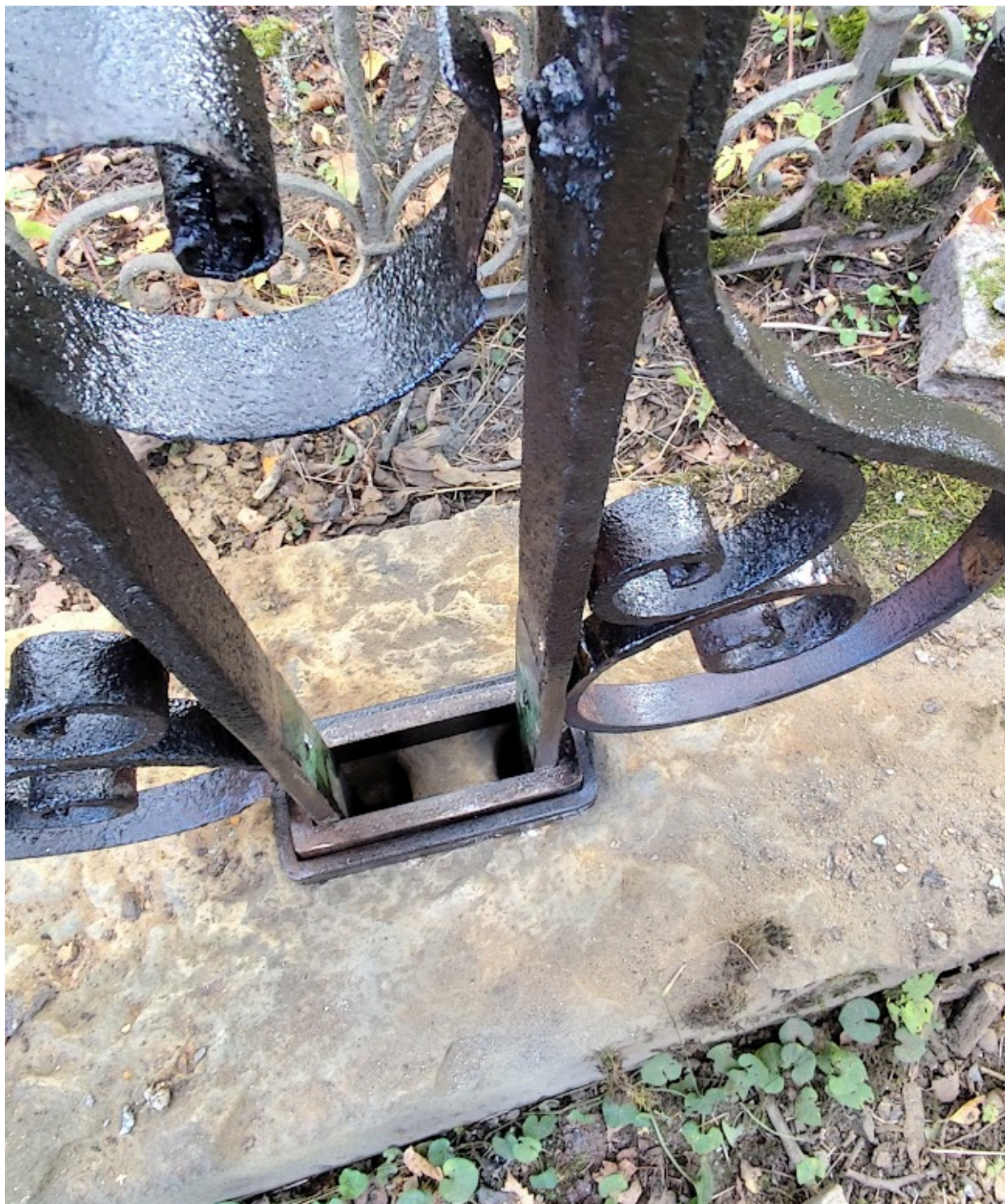
Joonis 28. Rist paigaldatud algsetesse avadesse aluskivis (autori foto).
