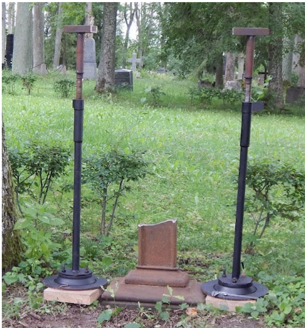
Joonis 4. Rakised malmristi haaradega osa paigaldamiseks (autori foto).
