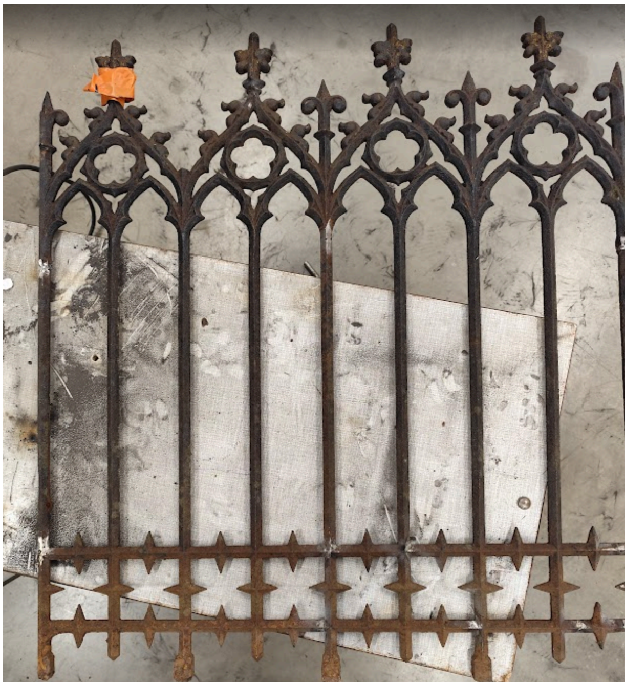
Joonis 16. Teine hulgi vigastustega aiapaneel peale keevitamist ja järeltöötlust (autori foto).
