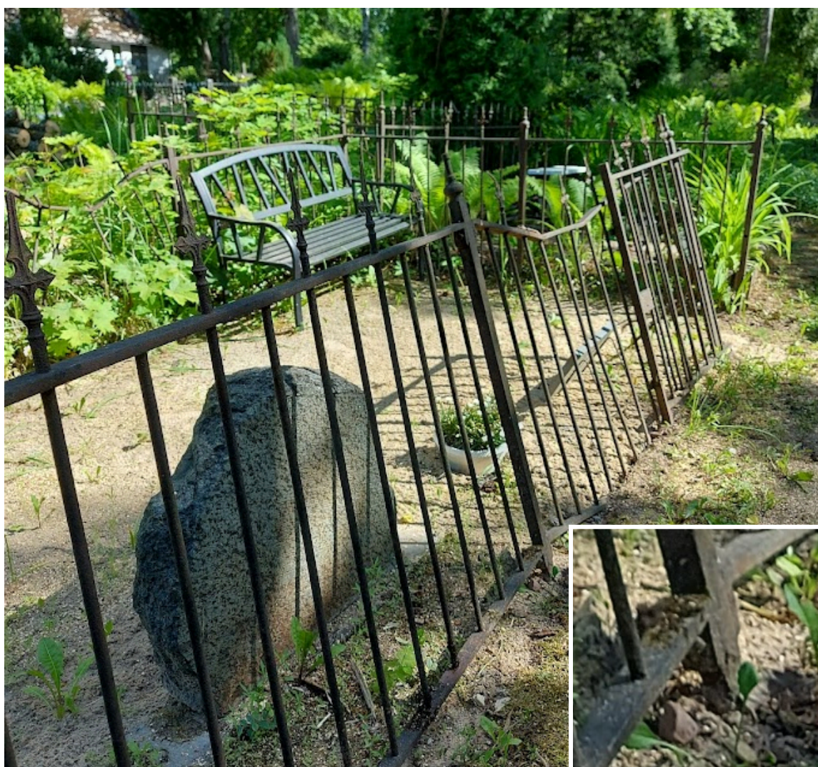
Joonis 10. Deformatsioonid aia esiküljel (Foto: Rutt Raigla).
