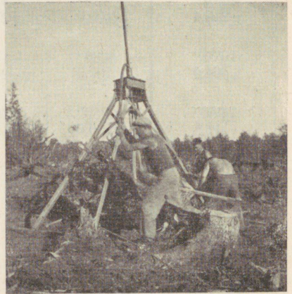
A. Laagriküla kännu- ja kivitõstmise masin.
