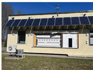
Tallinna Tehnikaülikooli liginullenergia testhoone
