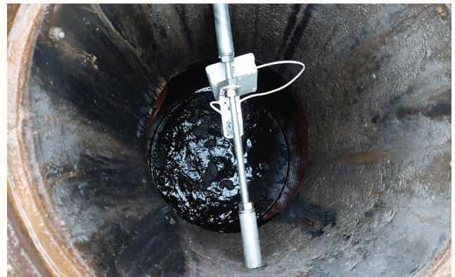
Joonis 2. Projekti käigus välja töötatud veetaseme andur Rakvere sademeveesüsteemis. Ivar Annus
