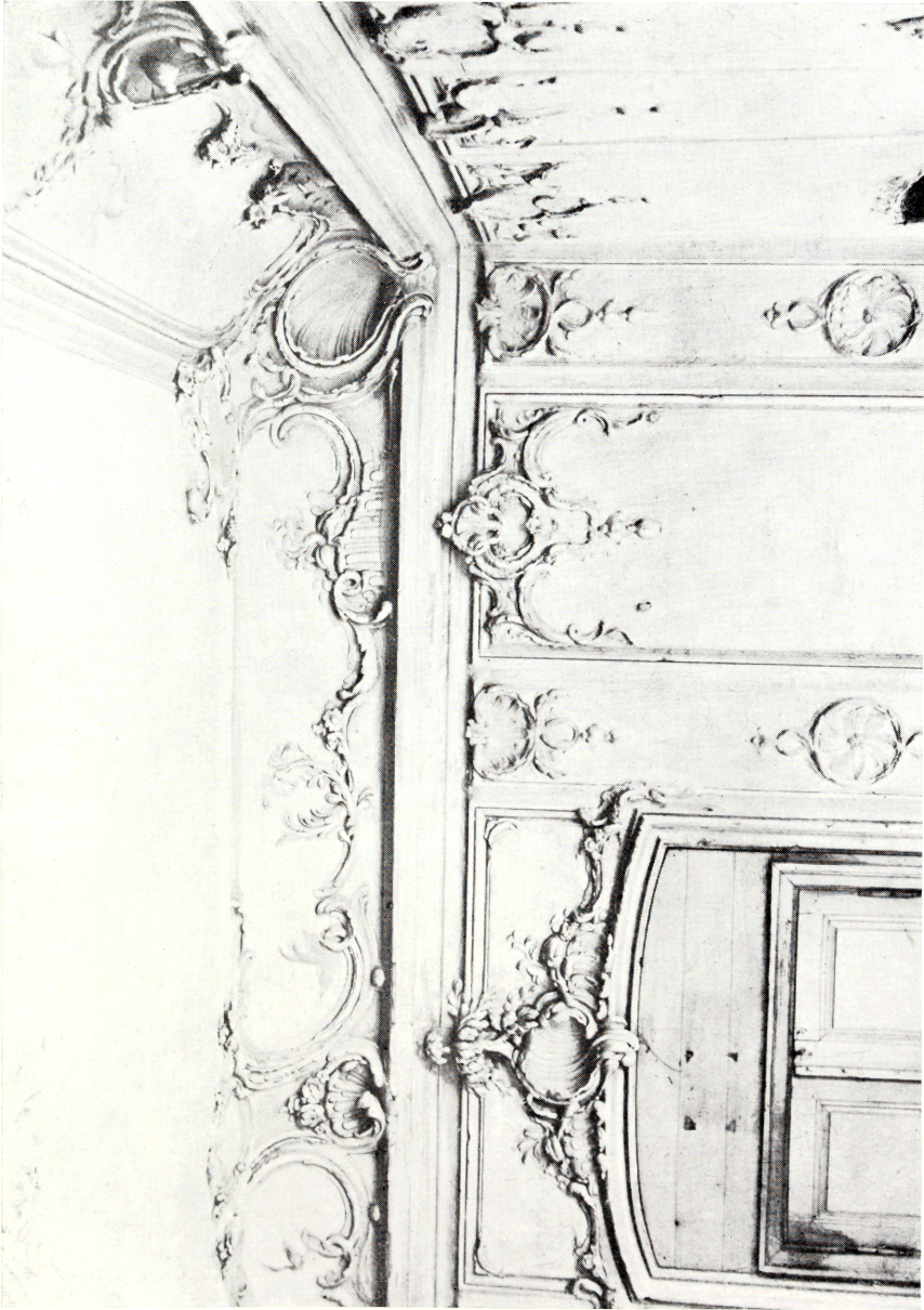
Schloss Pöltzamaa. Treppenraum.
