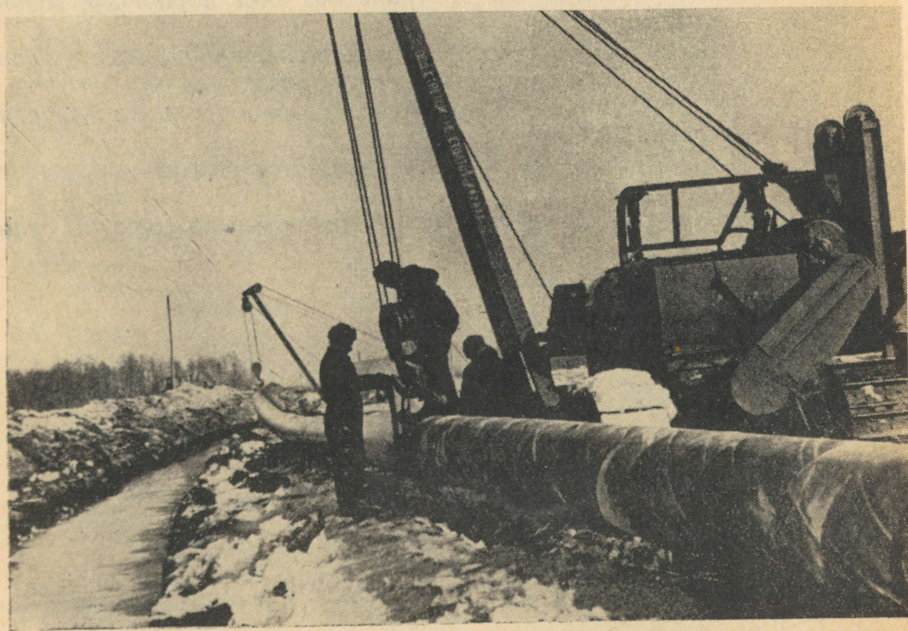
Рис. 92. Прокладка газового трубопровода Кохтла-Ярве — Таллин.
