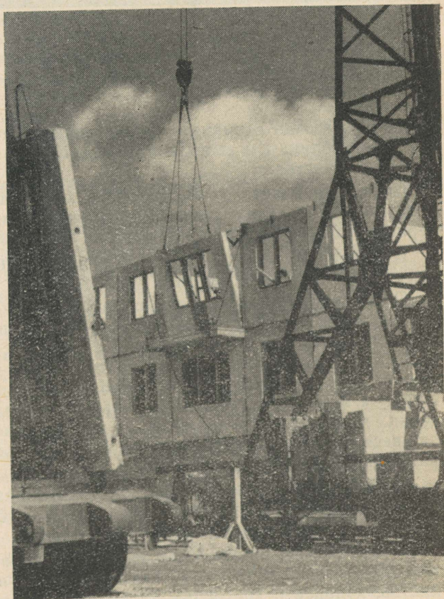
Рис. 60. В нашей республике широко развернулось жилищное строительство. Монтаж крупнопанельного жилого дома.
