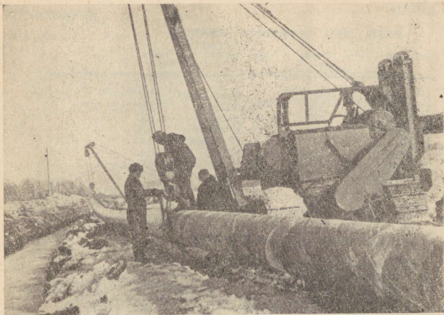
Joon. 96. Kohtla-Järve—Tallinna gaasijuhtme paigaldamine.
