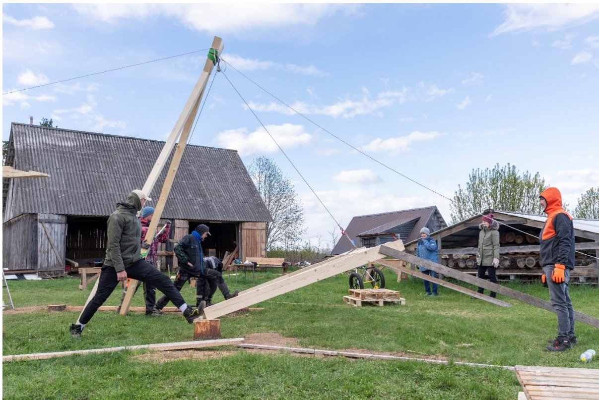
Joonis 70. Sektsioon 2 vinnamine (S. Urvak)
