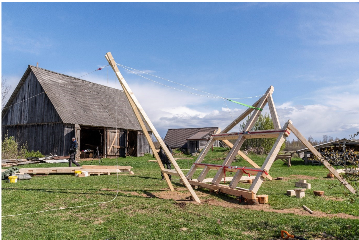
Joonis 68. Sektsioon 1 vinnamine langeva noole tehnoloogia abil (S. Urvak)
