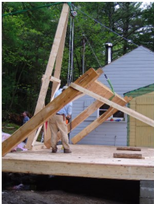
Joonis 22. Sektsiooni vinnamine fikseeritud A-kraana tööasendis (Mullen et al., s.a.)
