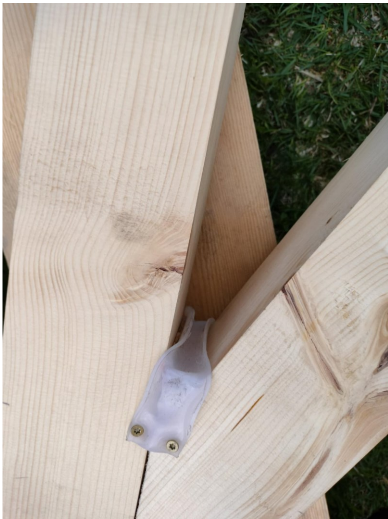
Joonis 51. Köiele vastav soon tõstekonstruktsiooni tipus (M. Kalm)
