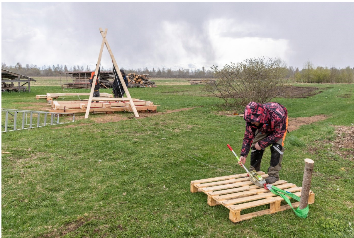
Joonis 66. A-kraana püstitamine seksioon 1 vinnamiseks (S. Urvak)
