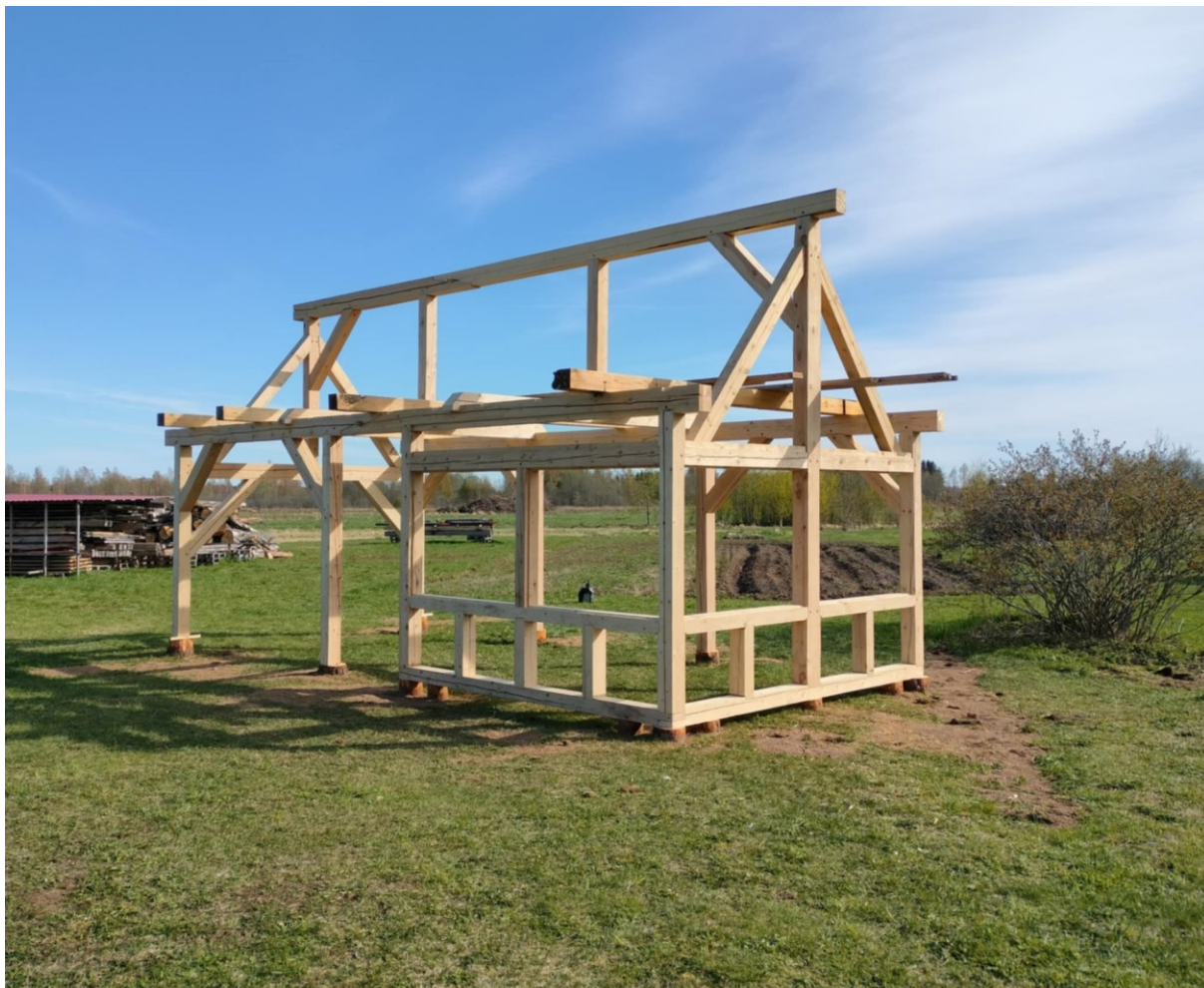
Joonis 72. Püstitatud konstruktsioon ( M. Kalm )
