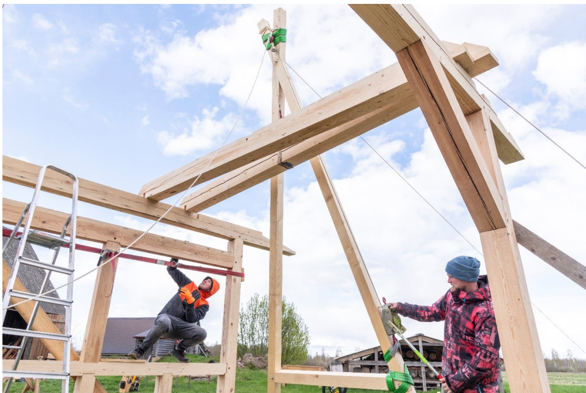
Joonis 69. Siduvate talade tõstmine (S. Urvak)
