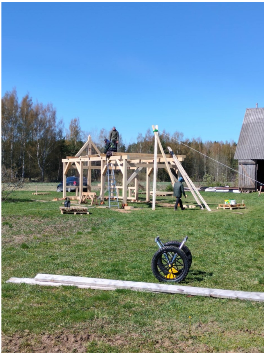
Joonis 71. Laepealsete konstruktsiooniosade tõstmine hoone otsast (M. Kalm)
