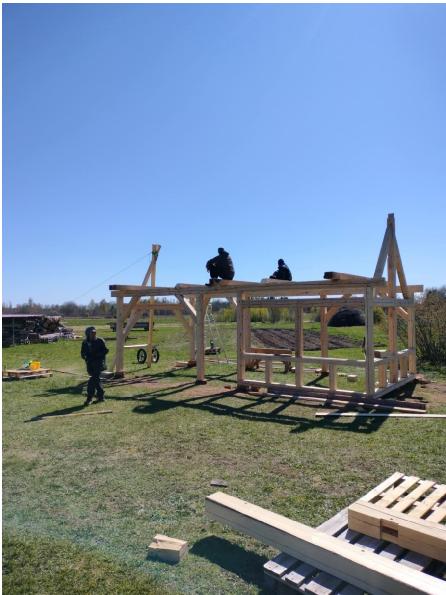
Joonis 60. A-kraana asetus vahelaie ehitusel (M. Kalm)
