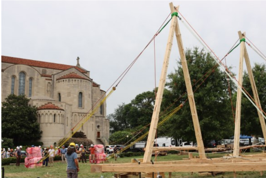
Joonis 21. Notre Dame koopiafermi püstitus Washington DC-s (Mullen et al., s.a.)
