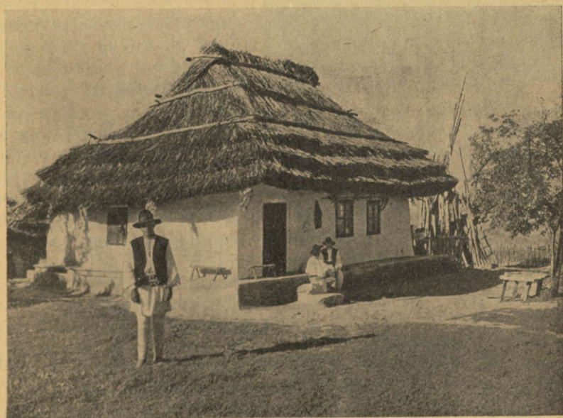
Joon. 95. Taluelamu tüüp Bessaraabiast. Majal on etteulatuv vundament ja õlgkatus. Majad ehitatakse siin savist.
