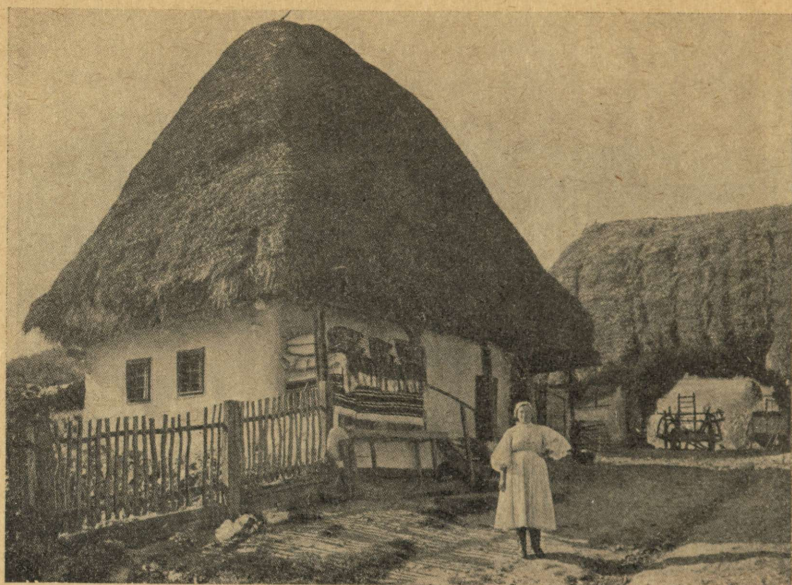
Joon. 92. Taluelamu Transilvaania kiltmaal. Ölgatus ehitatakse seinast kolm korda kõrgem. Kõrval saraalune.
