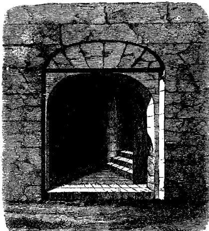
Входъ на лѣстницу, гдѣ былъ убитъ вел. кн. Андрей.
