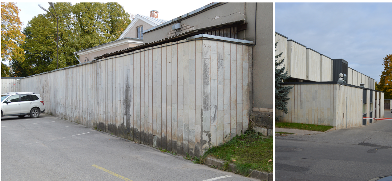
23–24. Piirdemüür ning piki kagufassaadi kulgev lisamaht.
