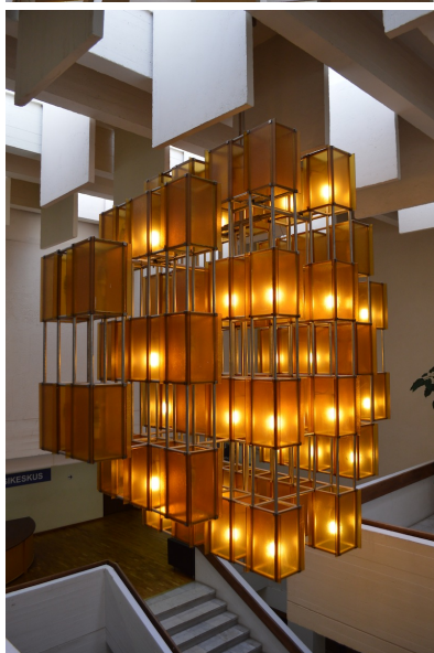
55–56. Trepikoja paarikaupa grupeeritud laetalad ja laest allalaskuvad paneelid; ühe klaaskupli avamismehhanism.
