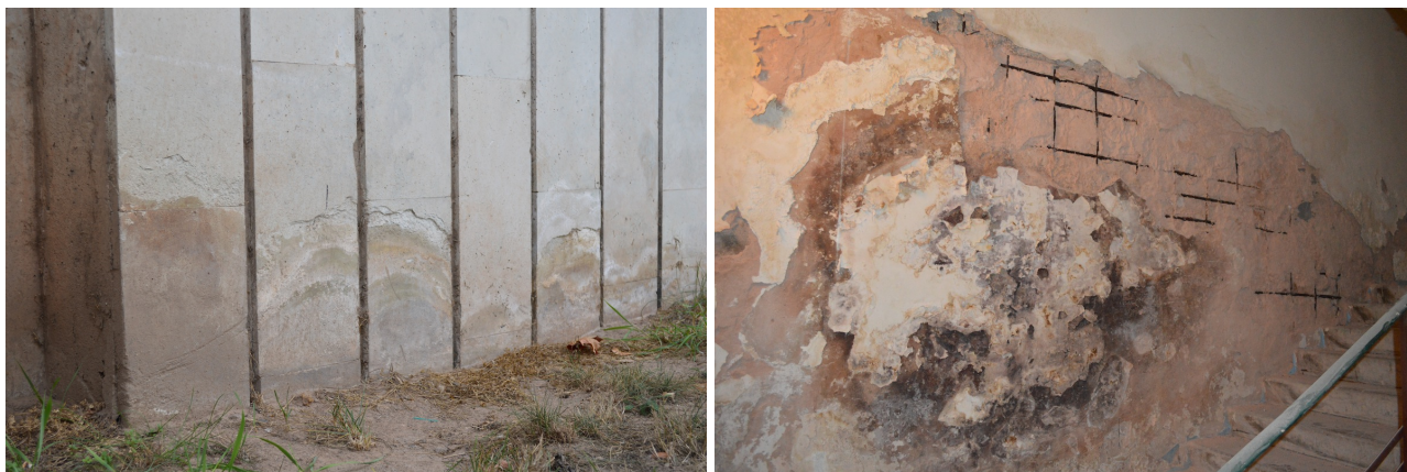
15–16. Niiskuskahjustused paeplaatidel ning hoidlatesse viiva trepikoja seinal. Siin ja edaspidi on kõik kaasaegsed jäädvustused autorite fotod, oktoober 2015.
