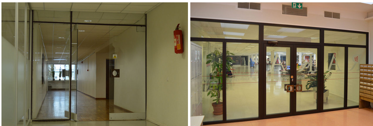
65–66. Klaasseinaga säilinud klaasuksed ning uued klaasuksed, millele on siirdatud algupärased käepidemed.
