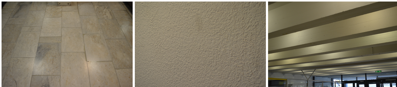
40–42. Garderoobi kiviparkett, seinte faktuurkrohv, raketisejälgedega raudbetoontalalagi.
