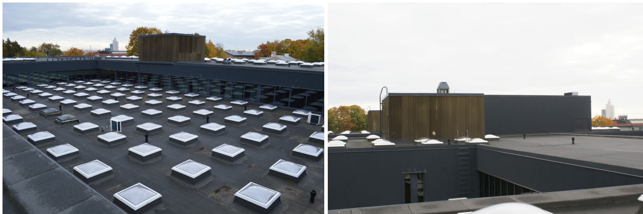
19–20. Vasakpoolsel pildil on näha üks katusekorruse süvenditest koos katuseakendega. Tumepruunid hoonemahud parempoolsel pildil on trepikodade püstakud katusel. Must maht nende taga on kaasajal lisatud ventilatsioonikamber.
