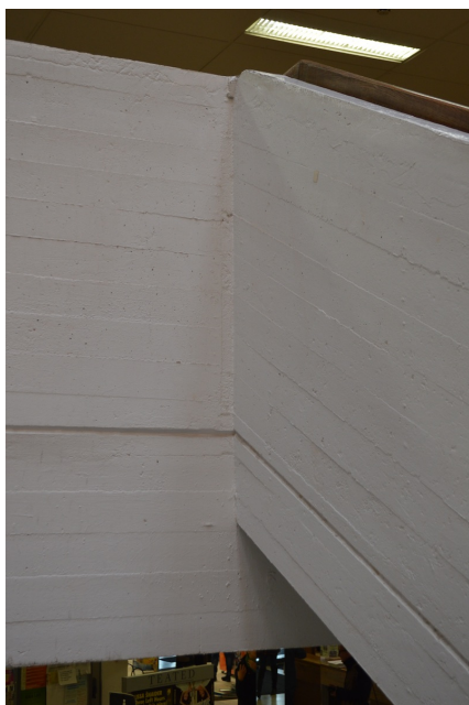
52–54. Raketisejäljed hooned peatrepil, profileeritud metallilehest põrandaliist ning brutalistlik trepikäepide.
