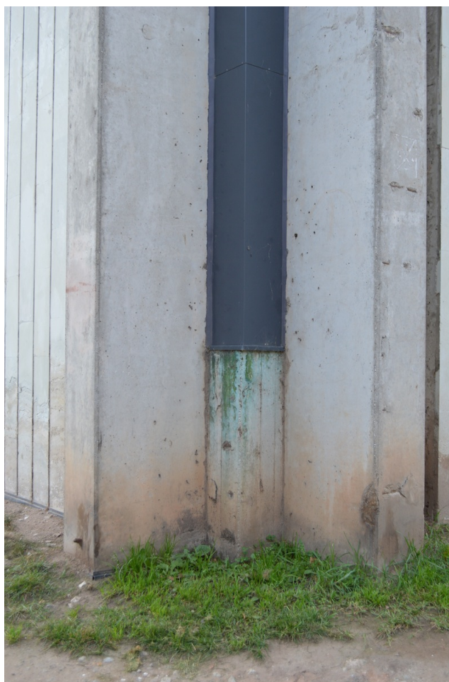
27–28. Vaade hoone nurgale Akadeemia tn poolt. Näha on kahte erinevat dolomiidi kasutust ning puhtaid betoonpindu. Parempoolsel pildil näha hoonenurkade teostus maapinna lähedal.
