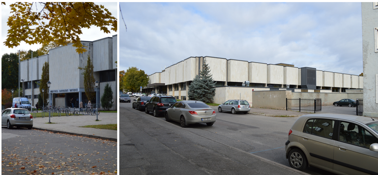
17–18. TÜ Raamatukogu peasissepääs ning konverentsisaali maht selle kohal vaadatuna põhjast ning tagumised fassaadid ühes plaat-varikatuse ning kaasajal lisatud trepikojaga vaadatuna lõunast.
