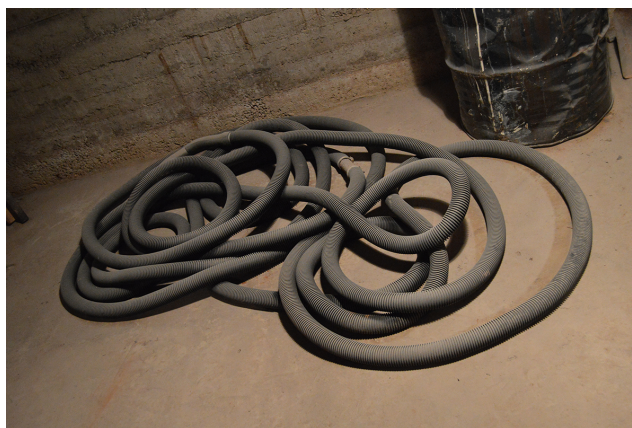
132–133. Sisseehitatud tolmuimemistorustik ning selle külge kinnitatav elastne toru.
