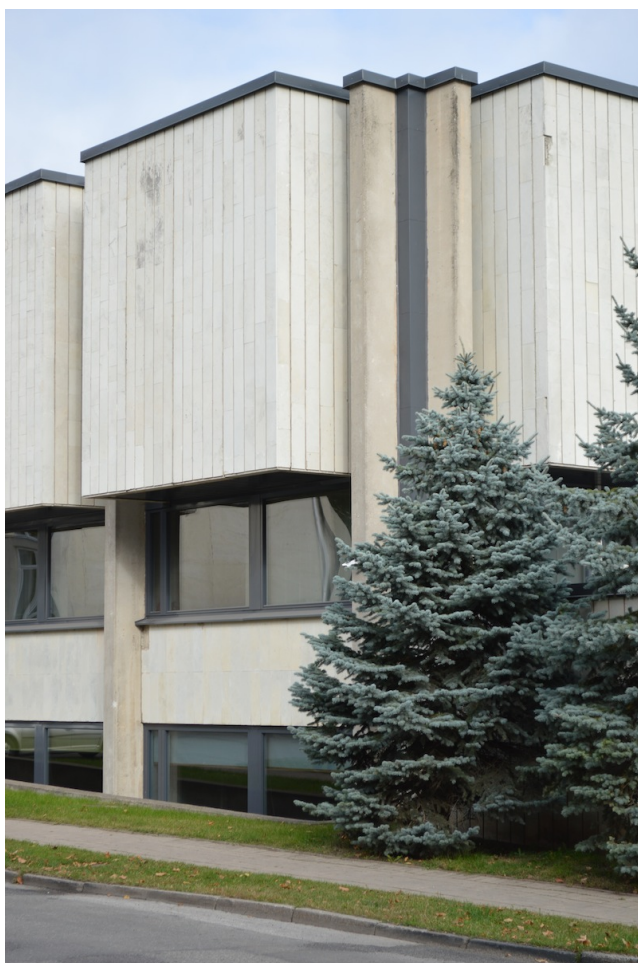
27–28. Vaade hoone nurgale Akadeemia tn poolt. Näha on kahte erinevat dolomiidi kasutust ning puhtaid betoonpindu. Parempoolsel pildil näha hoonenurkade teostus maapinna lähedal.
