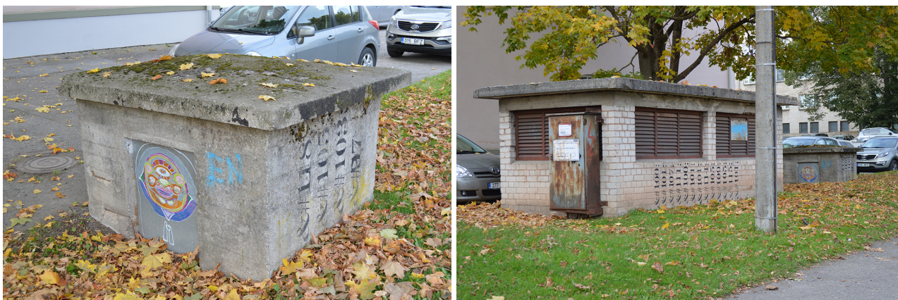
25–26. Üks kahest varjendi väljapääsust ning ventilatsioonikambri kõrvalkinnistul asuv maht.
