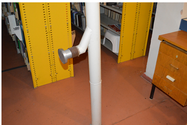
132–133. Sisseehitatud tolmuimemistorustik ning selle külge kinnitatav elastne toru.
